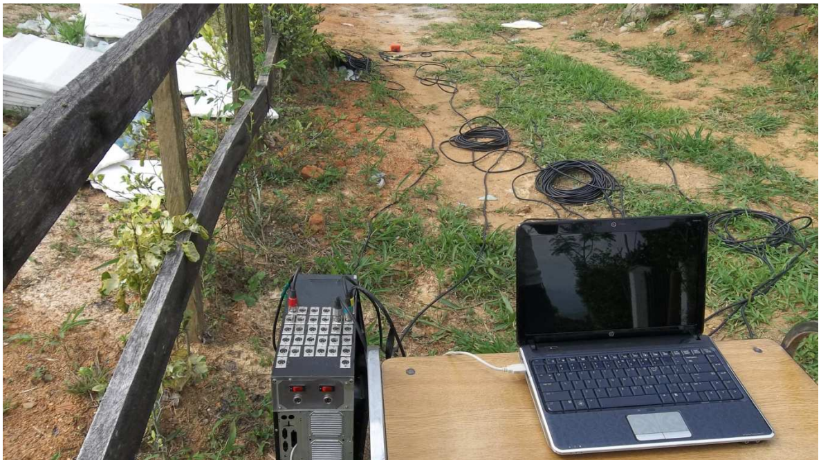
Figura 62. Conexión del sistema cableado Somersi
