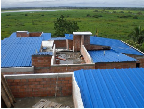
Figura 143. Cubierta Torre 2 Sur.
