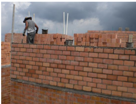
Figura 61. Construcción de muro
