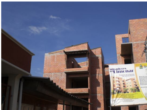
Figura 129. Viga cinta Torre 2 Norte.
