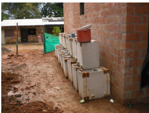
Figura 75. Suministro de lavaderos.
