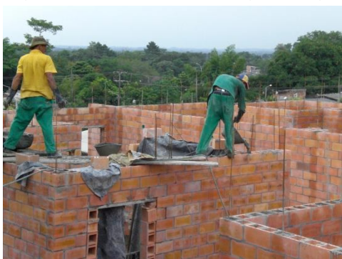
Figura 43. Inyección de grouting.
