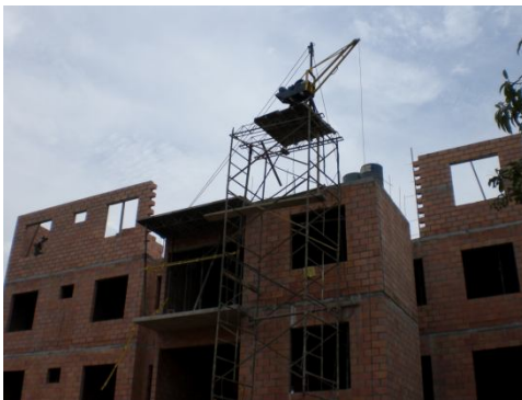
Figura 17. Quinto piso Torre 1 Sur.
