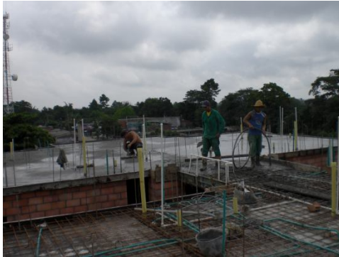
Figura 11. Fundida de losa en Torre B.
