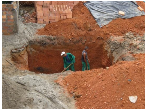
Figura 20. Excavación para tanque.
