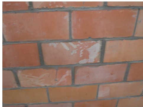
Figura 48. Bloques manchados.
