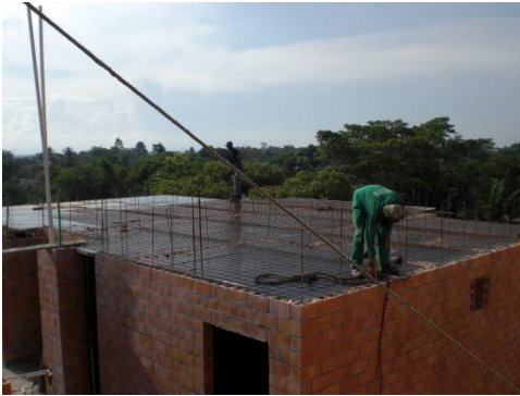
Figura 53. Armado losa torre A.
