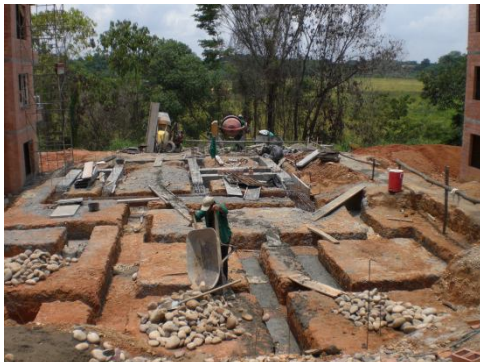
Figura 31. Cimentación Torre 1 Norte.
