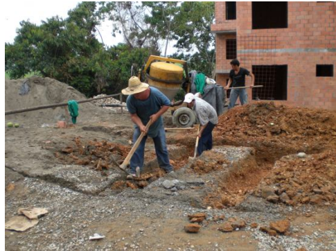
Figura 10. Excavación para cimentación.
