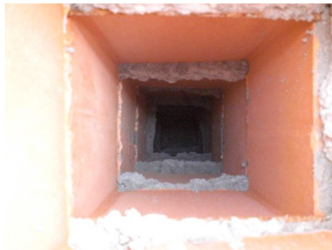
Figura 40. Celdas vacías.
