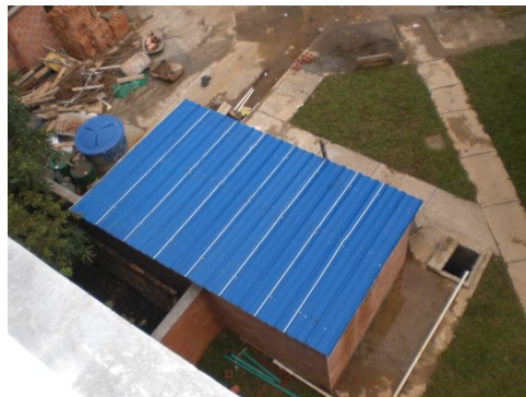
Figura 132. Cuarto de maquinas y basuras.
