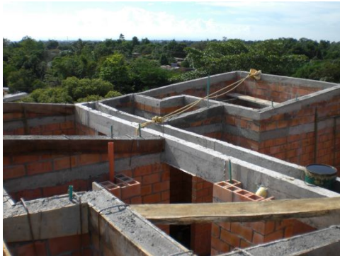
Figura 59. Vigas cinta Torre B.
