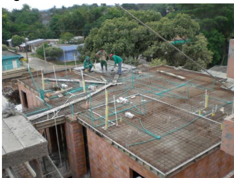
Figura 35. Fundida losa Torre A.
