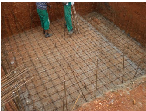
Figura 29. Refuerzo fondo de tanque. Figura 30. Refuerzo paredes de tanque.
