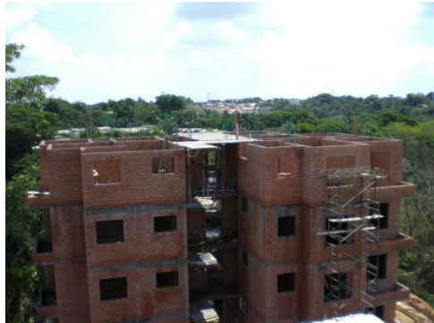
Figura 56. Placa de tanques Torre 2 Norte.
