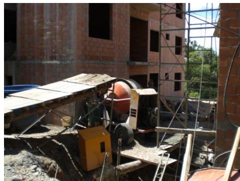
Figura 114. Mezclador de concreto.
