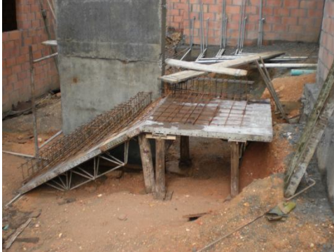
Figura 15. Refuerzo de escalera.
