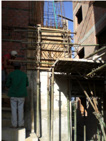
Figura 127. Escalera Norte tramo 3.
