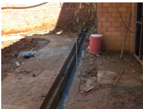
Figura 107. Cárcamo fundido.
