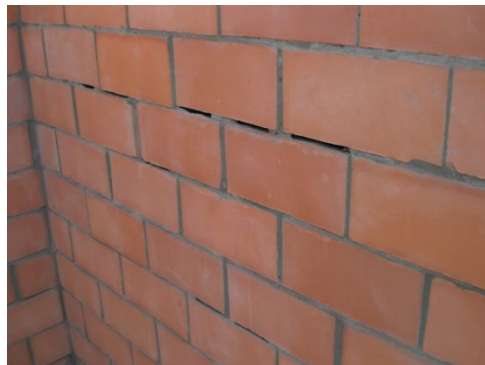
Figura 18. Juntas deficientes.
