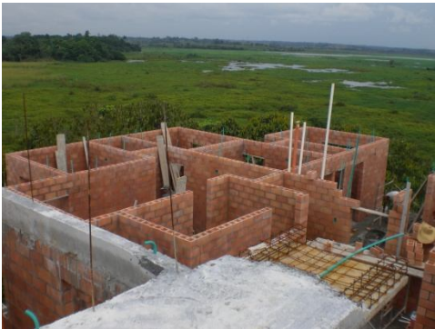
Figura 81. Piso 5 Torre 2 Sur.
