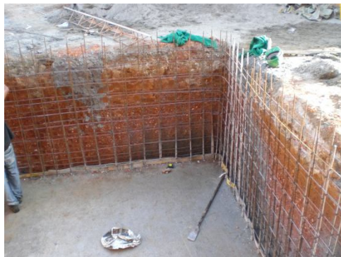
Figura 29. Refuerzo fondo de tanque. Figura 30. Refuerzo paredes de tanque.
