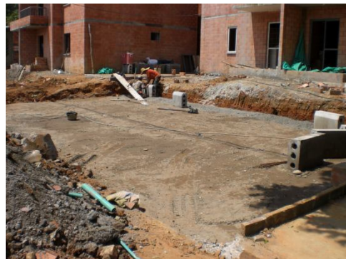
Figura 84. Explanación zona de parqueo.
