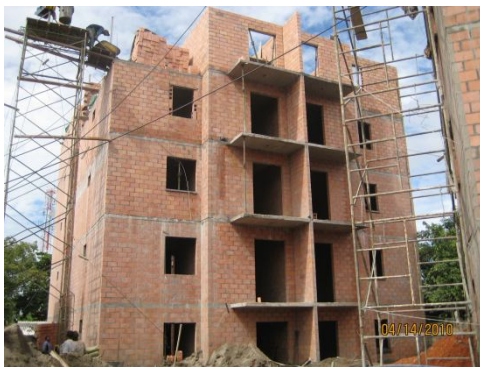
Figura 27. Torre B en quinto piso.
