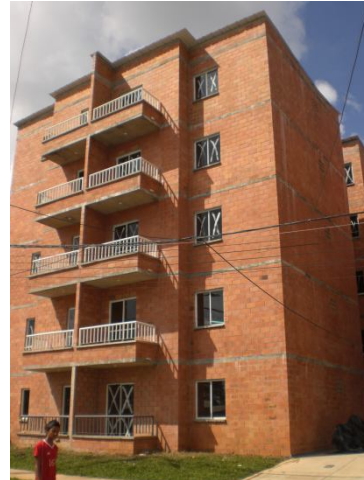
Figura 140. Torre B a la fecha
