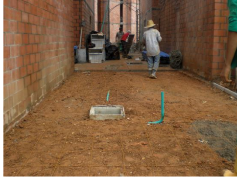
Figura 78. Construcción de andenes.
