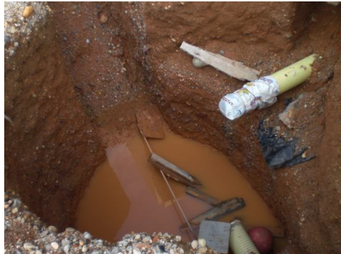
Figura 90. Aseo de la obra.
