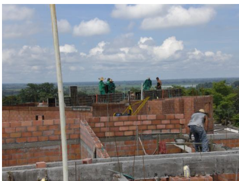
Figura 51. Armado vigacanal Torre C.
