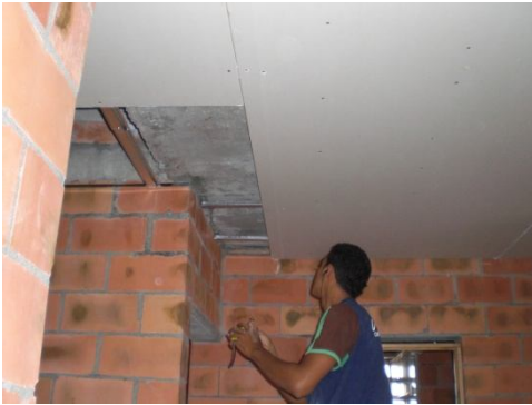
Figura 133. Instalación de cielorraso.
