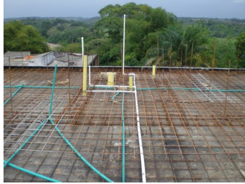
Figura 6. Encofrado de losa en Torre B.
