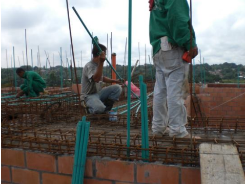
Figura 71. Armado placa de tanques.
