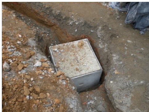
Figura 62. Caja para alumbrado público.
