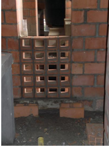
Figura 45. Muro calado en cocina.
