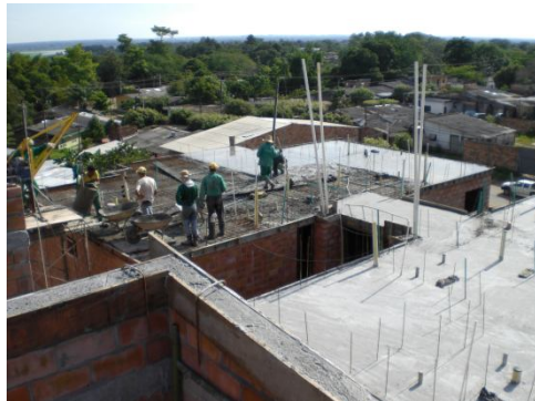
Figura 60. Fundida de losa en Torre A.
