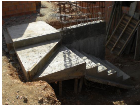
Figura 58. Tramo de escaleras.
