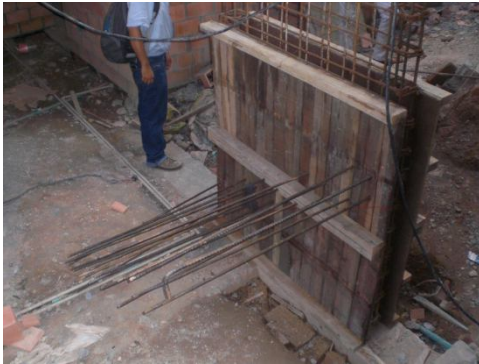
Figura 7. Encofrado escalera.
