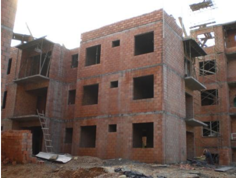
Figura 103. Mampostería Torre 1 Norte.
