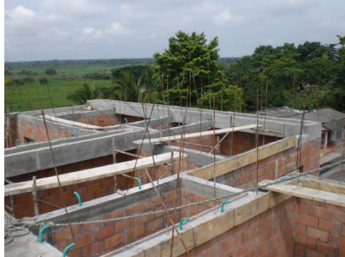
Figura 72. Vigas cinta Torre 1 Sur.
