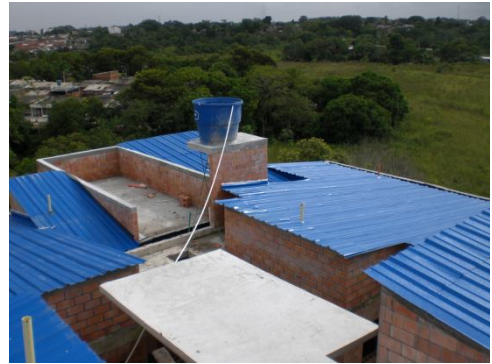
Figura 144. Cubierta Torre 2 Norte.
