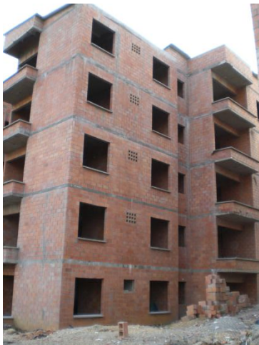
Figura 145. Torre 1 Sur a la fecha.
