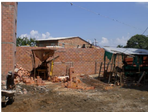
Figura 83. Muro de cerramiento.
