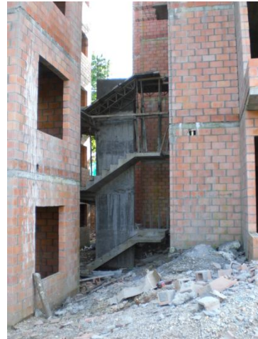
Figura 128. Escalera Sur tramo 5.
