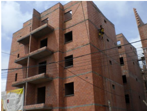
Figura 67. Limpieza de fachadas.
