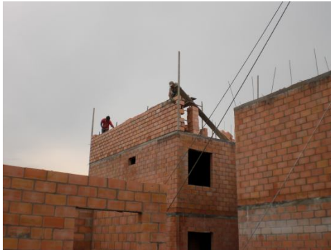
Figura 19. Levantamiento de muro.
