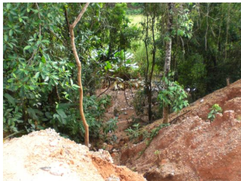
Figura 98. Humedal junto a la Torre 2 Norte.
