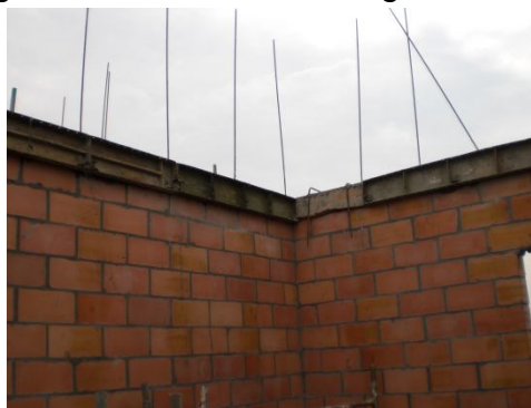
Figura 36. Encofrado de vigas cinta.
