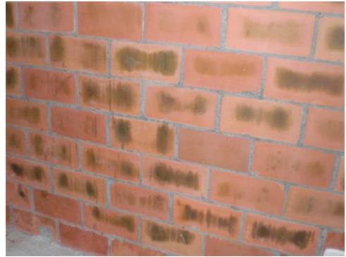
Figura 134. Eflorescencias en muros.
