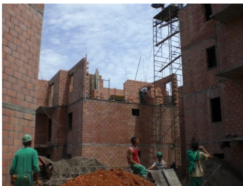
Figura 21. Piso tres Torres A.
