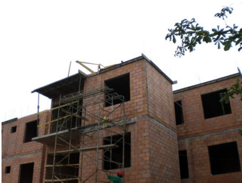
Figura 9. Encofrado Torre 1 Sur.
