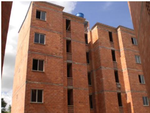
Figura 141. Torre C a la fecha.
