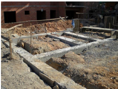
Figura 33. Arranque refuerzo vertical.
