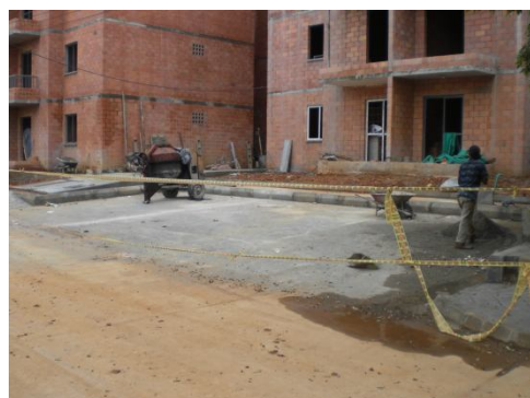
Figura 86. Zona de parqueo fundida.
