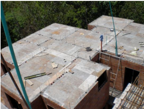
Figura 55. Encofrado Torre 2 Sur.
