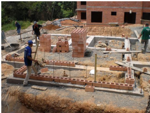
Figura 41. Colocación primera hilada.
