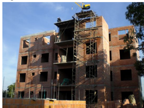
Figura 50. Fachada Torre 1 Sur.
