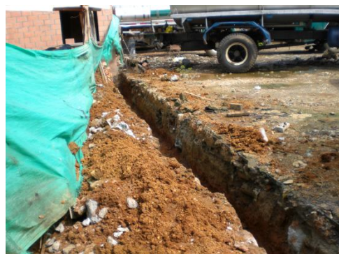
Figura 70. Excavación para cerramiento.
