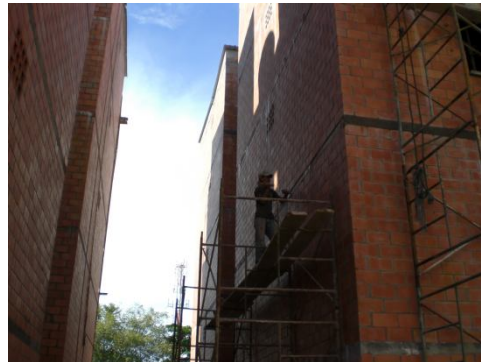
Figura 124. Reparación de bordes de placas.
