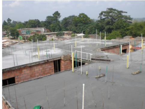
Figura 12. Losa nueva Torre B
