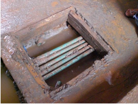
Figura 77. Caja de inspección eléctrica.
