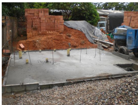
Figura 76. Tapa de tanque fundida.
