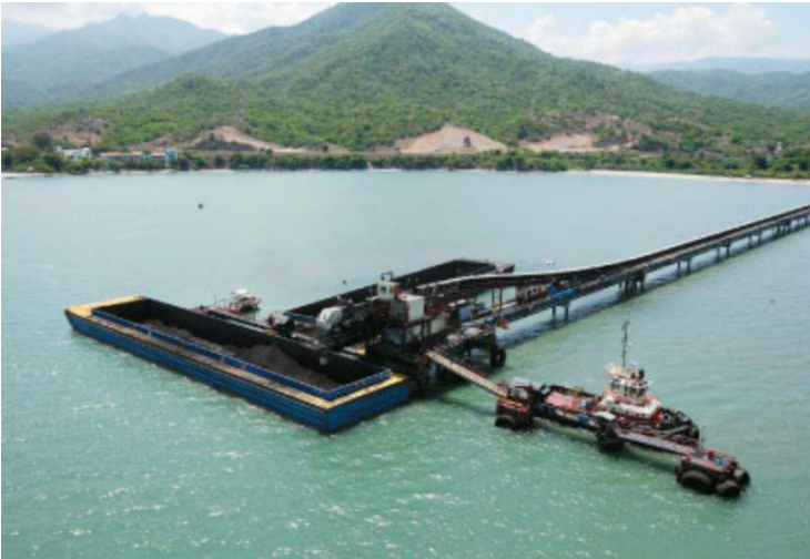
Figura 8. Muelle de Puerto Drummond. Carbón siendo descargado en barcaza
