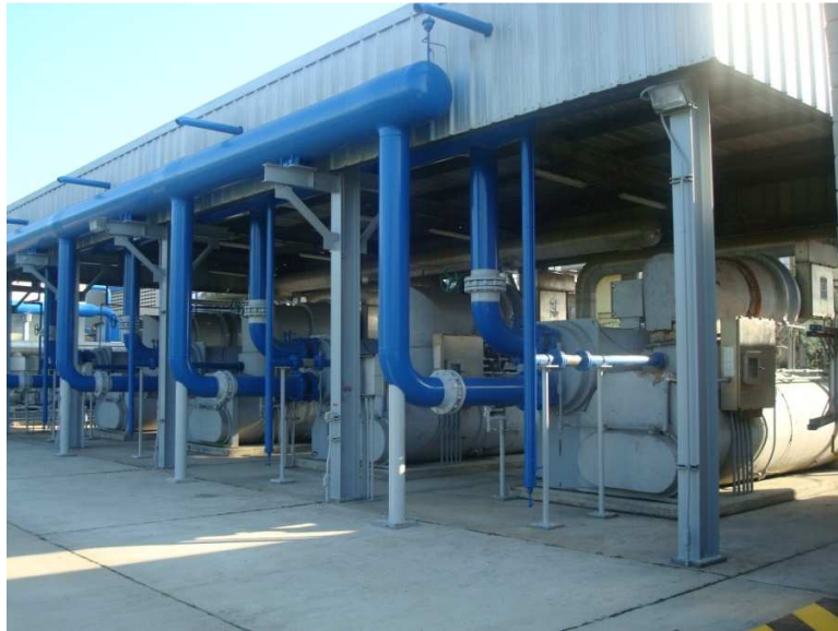
Figura 37. Instalación in situ de los chillers
