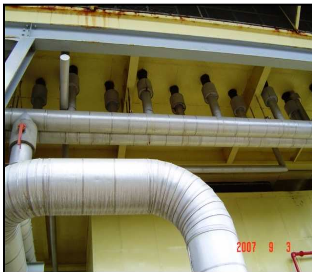
Figura 41. Entrada a la casa de filtros
