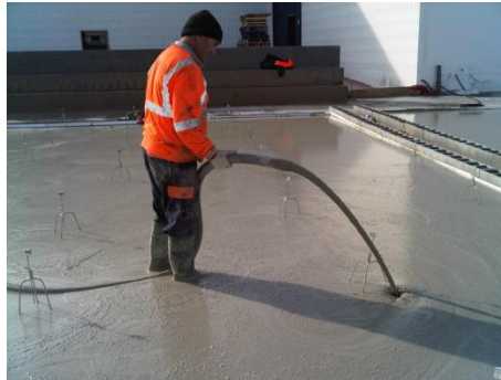
Figura 7. Concreto Autonivelante o Tremie
