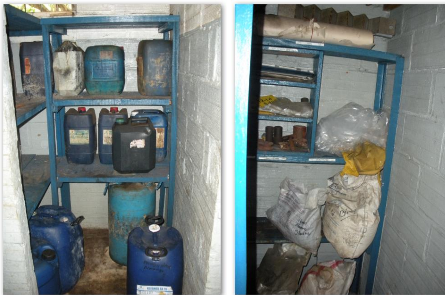
Ilustración 131. Almacenamiento de productos químicos
