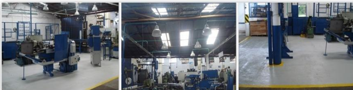
Ilustración 30. Línea de gas después de la jornada
