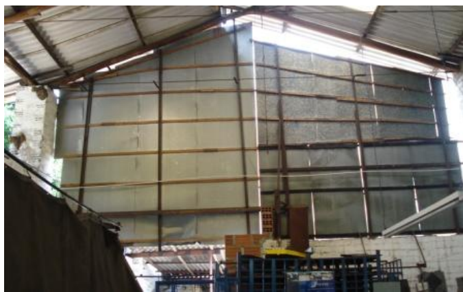
Ilustración 128. Pared en lámina para evitar los rayos solares y el agua.
