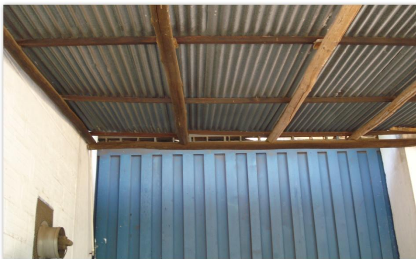
Ilustración 141. Techo en zinc y madera
