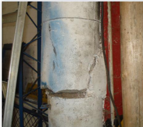
Ilustración 78. Columna partida.
