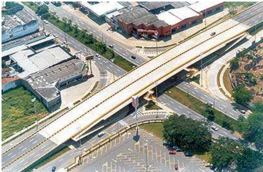
Figura 14. INTERSECCIÓN CALLE 80 ENTRE CRA. 25 Y 25.
