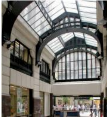
Figura 2. Túnel solar en Santiago de Chile [10].
