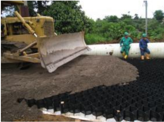
Imagen 21: Proceso de relleno de geoceldas
