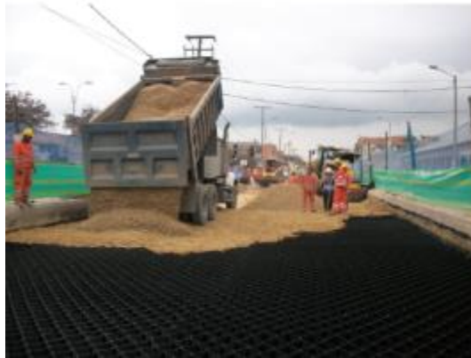
Imagen 10: Desarrollo del proceso constructivo con el SCC
