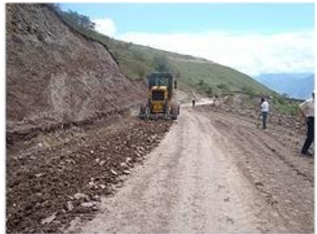
Imagen 4: Mejoramientos de Brasante con cemento, cal y químicos
