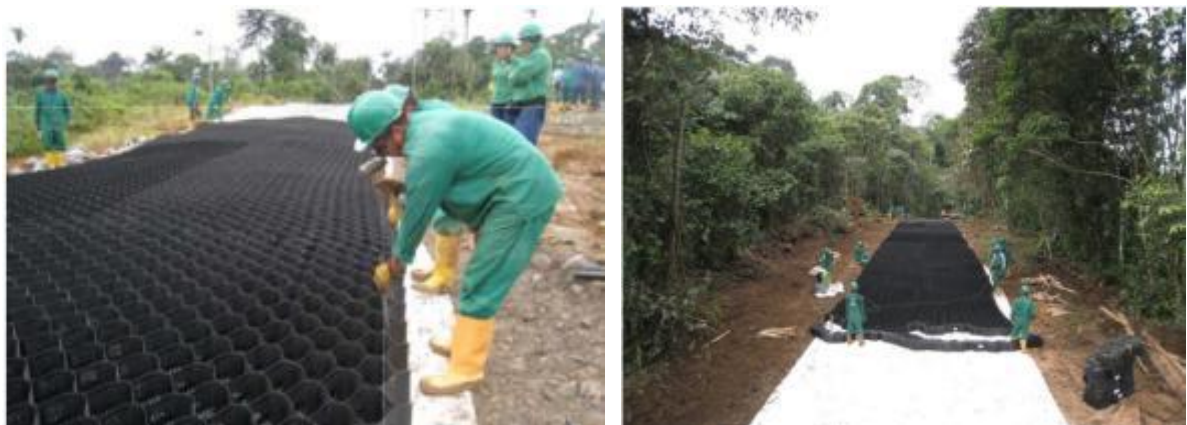
Imagen 20: Proceso de instalación del SCC sobre geotextil
