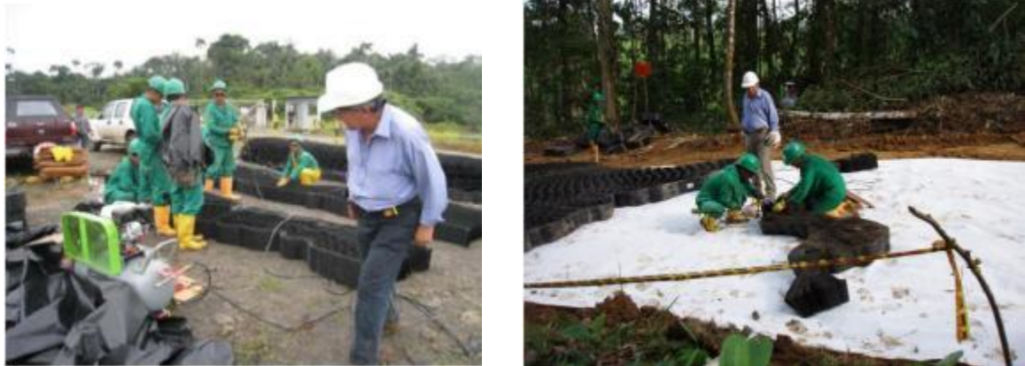
Imagen 19: Presentación del SCC e instalación del Geotextil
