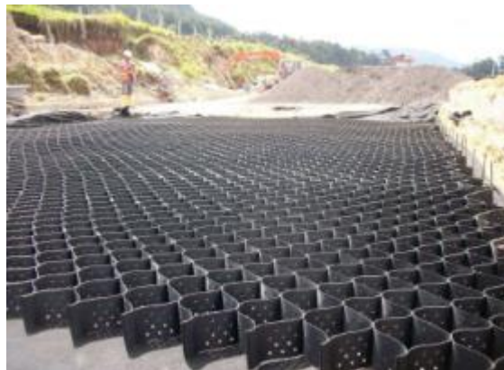
Imagen 9: Instalación del SCC como refuerzo de la estructura
