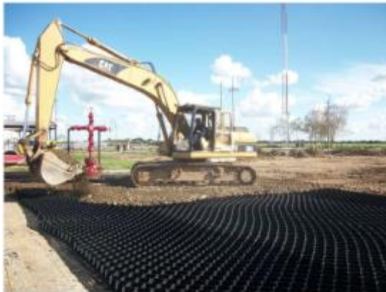
Imagen 8: Desarrollo constructivo instalación refuerzo SCC
