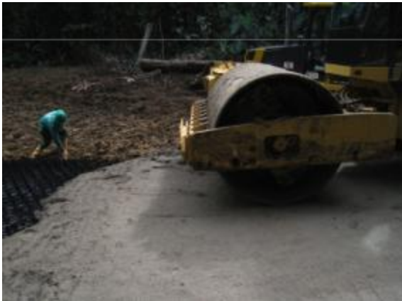
Imagen 22: Proceso de compactación de geoceldas
