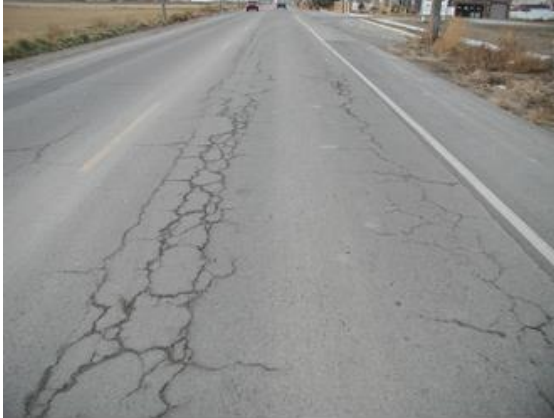
Imagen 6: Pavimento con características de fatiga
