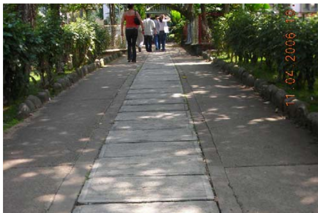
Figura 4.13. Cárcamo de la acometida Biblioteca – Sótano Administración
