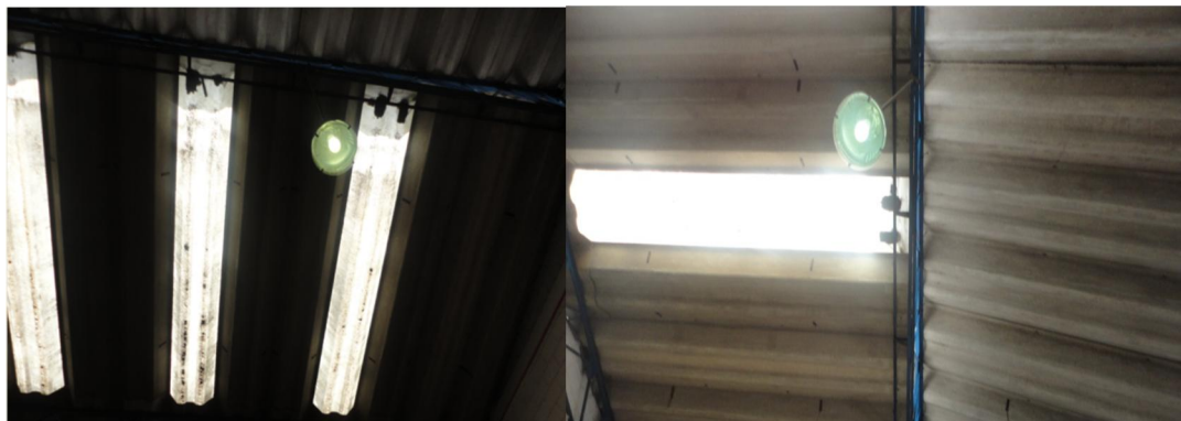
Imagen 26. Cambio de luces en la planta
