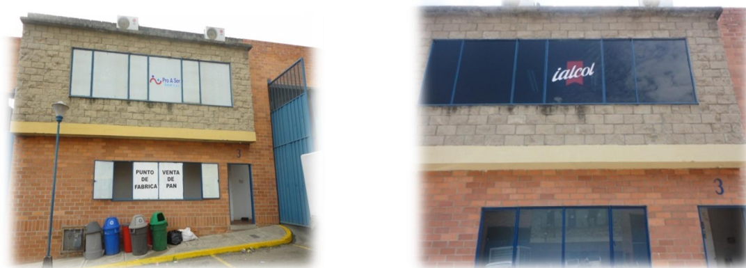
Imagen 1. Entrada principal IALCOL S.A.S.
