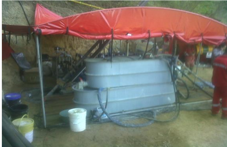
Figura 13. Plataforma de perforación en Guadalupe, Antioquia. Fuente. Departamento de operaciones.
