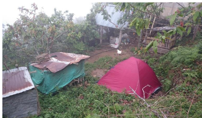
Figura 83. Evidencia del estado de las edificaciones después del sismo del 10 de marzo del 2015 en Betulia Santander.
