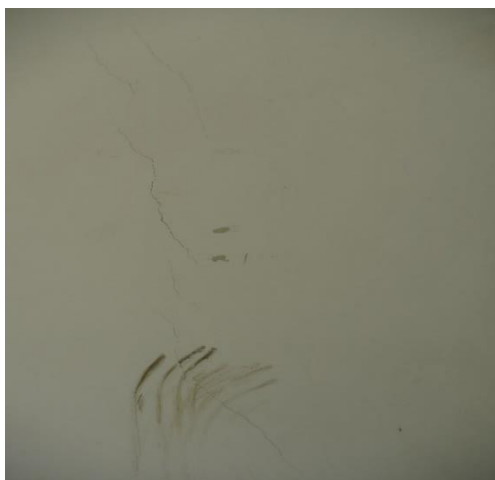
Figura 56. Muro de la Universidad industrial de Santanderque presento grietas leves tras el sismo del 10 de marzo del 2015.
