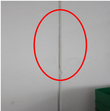
Figura 44. Grietas en las conexiones en San Andresito Centro Bucaramanga. Adaptado: Alcaldía de Floridablanca (Floridablanca. 2015). Galería Fotográfica del reporte de daños provocados por el sismo del 10 de marzo del 2015. Floridablanca-Santander.
