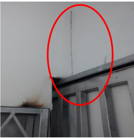
Figura 44. Grietas en las conexiones en San Andresito Centro Bucaramanga. Adaptado: Alcaldía de Floridablanca (Floridablanca. 2015). Galería Fotográfica del reporte de daños provocados por el sismo del 10 de marzo del 2015. Floridablanca-Santander.
