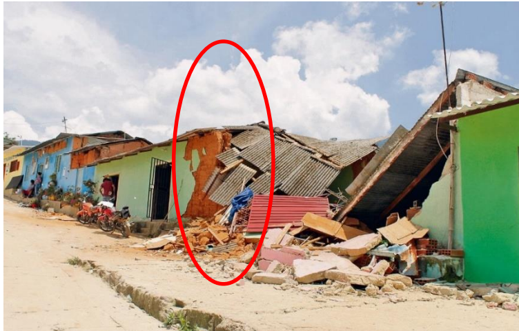
Figura 30. Casa colapsada totalmente y casas vecinas afectadas con gravedad debido al sismo del 10 de marzo del 2015
