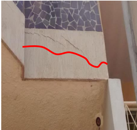
Figura 49. Localización de fisuras Horizontales en la edificación GAF del área metropolitana de Bucaramanga afectada por el sismo. Adaptado: Alcaldía de Floridablanca (Floridablanca. 2015). Galería Fotográfica del reporte de daños provocados por el sismo del 10 de marzo del 2015. Floridablanca-Santander.
