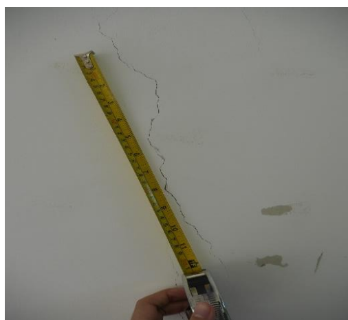
Figura 56. Muro de la Universidad industrial de Santanderque presento grietas leves tras el sismo del 10 de marzo del 2015.
