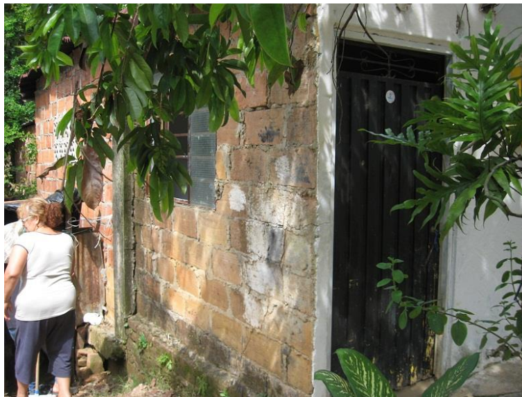
Figura 21. Edificación en mampostería confinada, que no sigue los parámetros exigidos por la NSR-10 y es afectada en Piedecuesta Santander, por el sismo del 10 de marzo del 2015. Adaptado: Alcaldía de Los Santos (2015). Acta Diligencia de Demolición Sobre Vivienda No Habitable y en Estado de Ruina. Los Santos-Santander.
