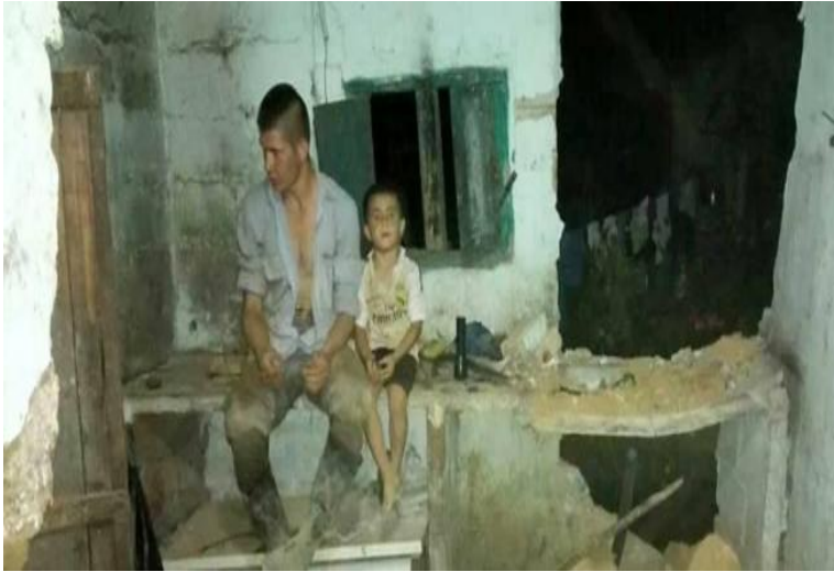
Figura 26. Casa destruida en Rionegro Santander por el sismo del 10 de marzo del 2015. Adaptado: Alcaldía de Rionegro (Rionegro, 2015). Galería Fotográfica del reporte de daños provocados por el sismo del 10 de marzo del 2015. Rionegro-Santander.
