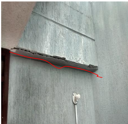
Figura 49. Localización de fisuras Horizontales en la edificación GAF del área metropolitana de Bucaramanga afectada por el sismo. Adaptado: Alcaldía de Floridablanca (Floridablanca. 2015). Galería Fotográfica del reporte de daños provocados por el sismo del 10 de marzo del 2015. Floridablanca-Santander.
