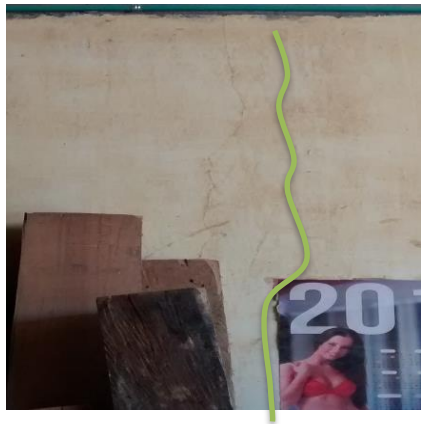
Figura 48. Localización de fisuras verticales en estructura del área metropolitana de Bucaramanga afectada por el sismo Adaptado: Alcaldía de Floridablanca (Floridablanca. 2015). Galería Fotográfica del reporte de daños provocados por el sismo del 10 de marzo del 2015. Floridablanca-Santander.
