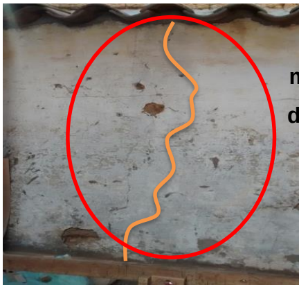
Figura 48. Localización de fisuras verticales en estructura del área metropolitana de Bucaramanga afectada por el sismo Adaptado: Alcaldía de Floridablanca (Floridablanca. 2015). Galería Fotográfica del reporte de daños provocados por el sismo del 10 de marzo del 2015. Floridablanca-Santander.
