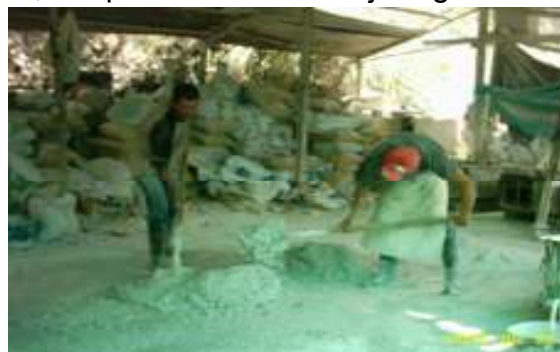
Figura 8: Mezcla manual
