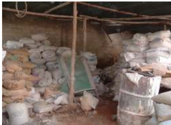
Figura 12: Estado de la bodega de granito
