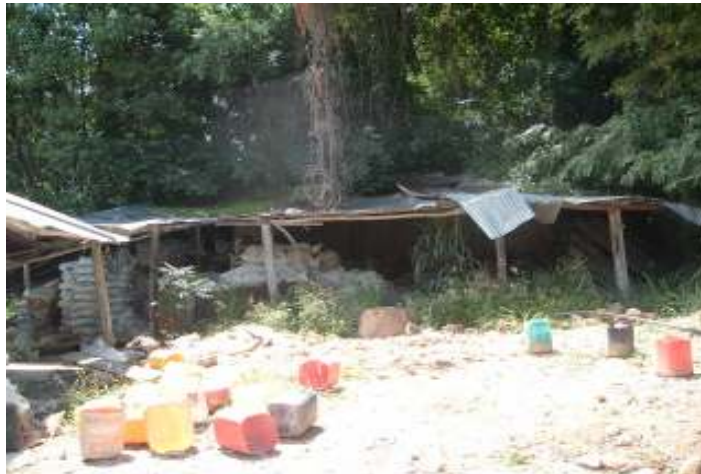
Figura 9: Estado de las instalaciones
