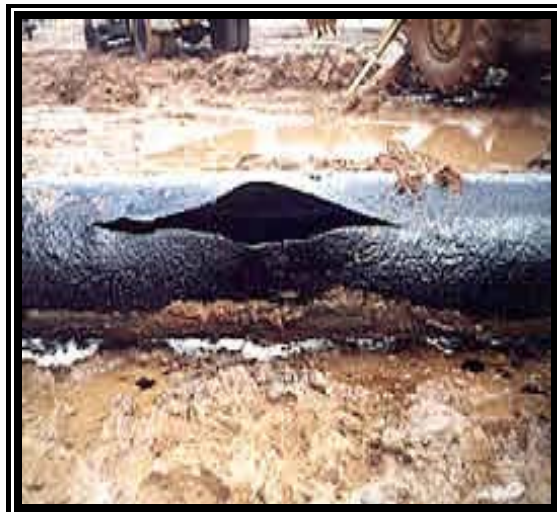
Figura 1. Oleoducto averiado por corrosión
