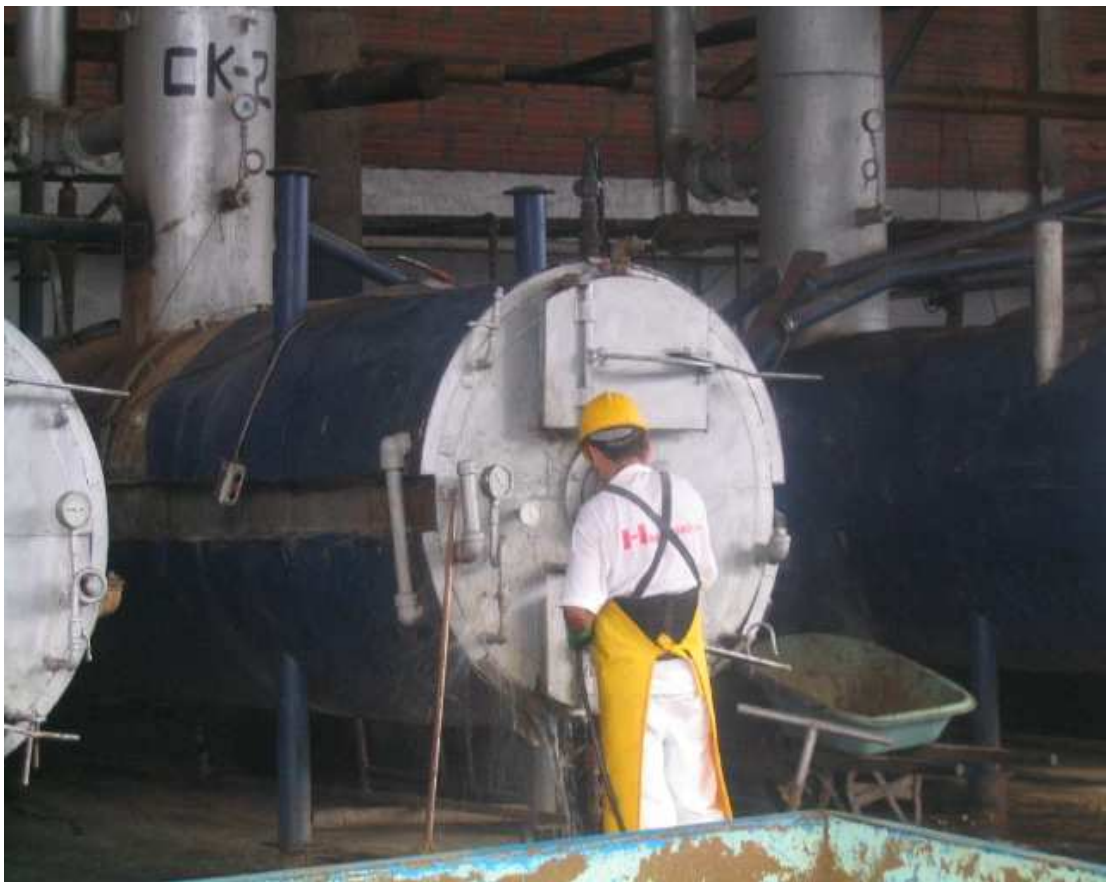
Figura 11. Líneas Distribución de Vapor
