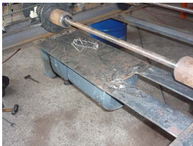
Figura 53. Montaje del motoreductor sobre estructura metálica.
