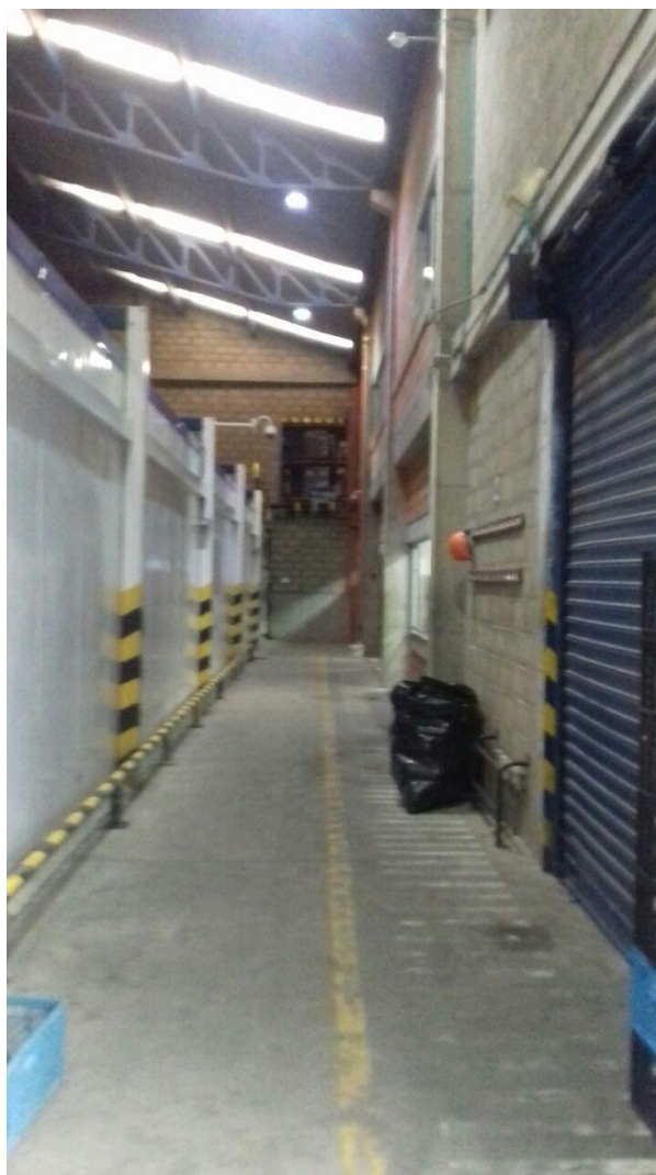
Imagen 10. Desechos dispuestos incorrectamente
