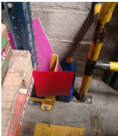
Imagen 18. Elementos ubicados incorrectamente
