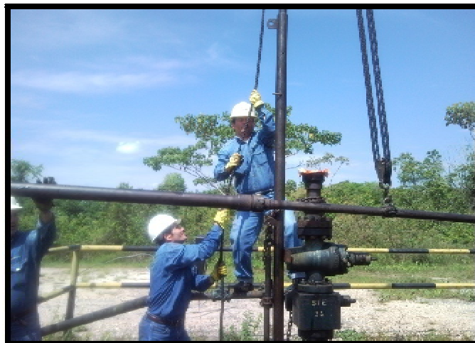
Imagen 1. Operadores instalando preventora en pozo Suerte 34 del Campo Provincia.
