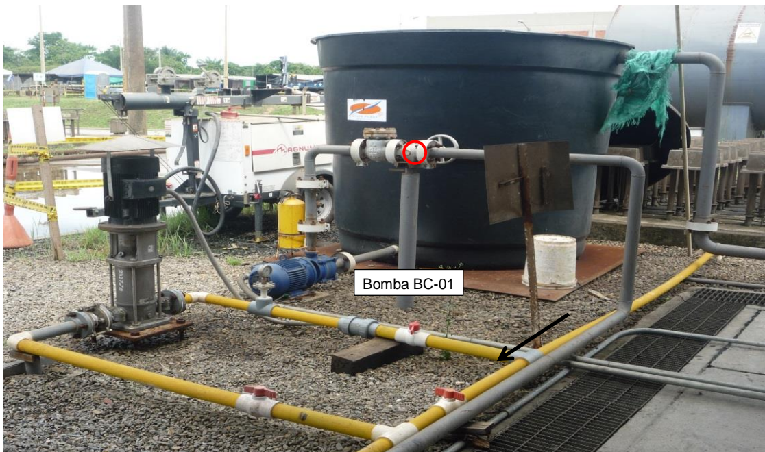
Figura 19. Alineación agua motivante hacia generador.
