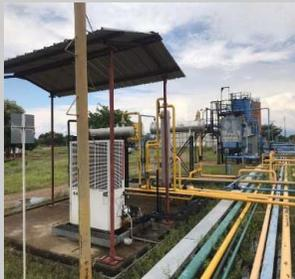
Después de los separadores, el gas sale a 165°F pasa a los intercambiadores de calor y baja a 65 °F, le quitan la humedad y de ahí pasa al pulmón de succión compresores.
