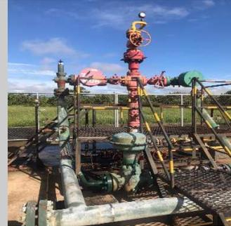
MOR7, produce 400 miles pies 3 de gas diarios. Ese gas que producen, lo usan para autoconsumo y si sobra lo inyectan al gasoducto, por medio de los compresores.
