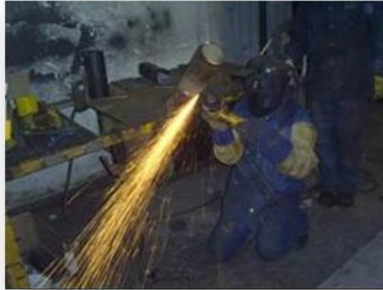
Figura 5 Limpieza con pulidora
