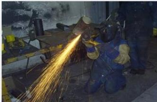
Figura 21 Limpieza del cordón de soldadura.
