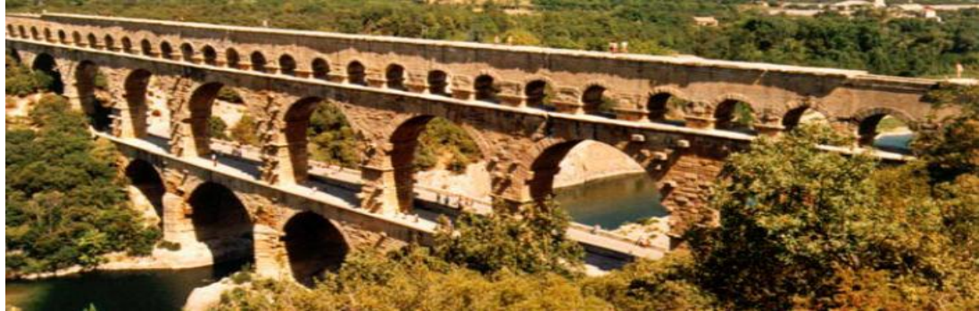
Figura 1. Acueducto Pon du Gard, Nimes, Francia. Mampostería colocada en seco formando arcos superpuestos.
