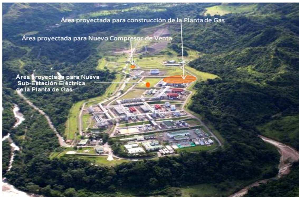
Fig. 4 Vista Aérea de la localización del Proyecto Planta de Gas Cupiagua.
