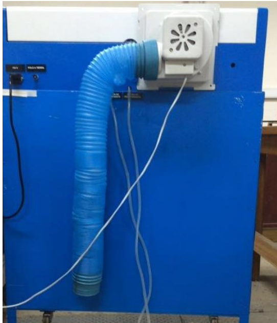
Figura 68. Instalación del extractor de aire.
