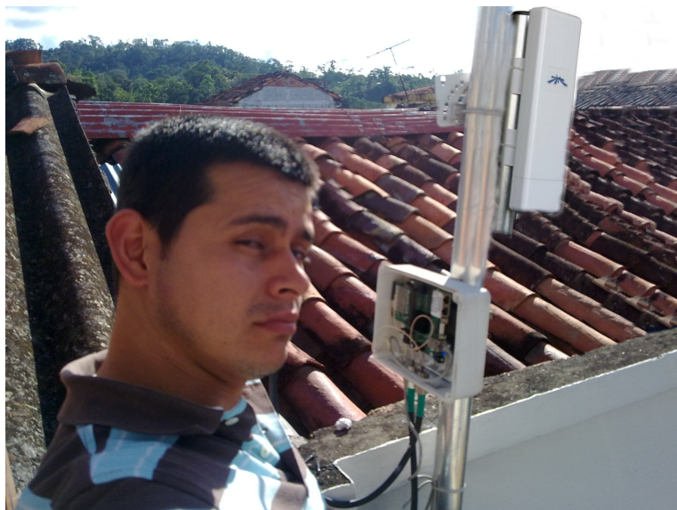
Imagen 237 Instalación de NanoStation
