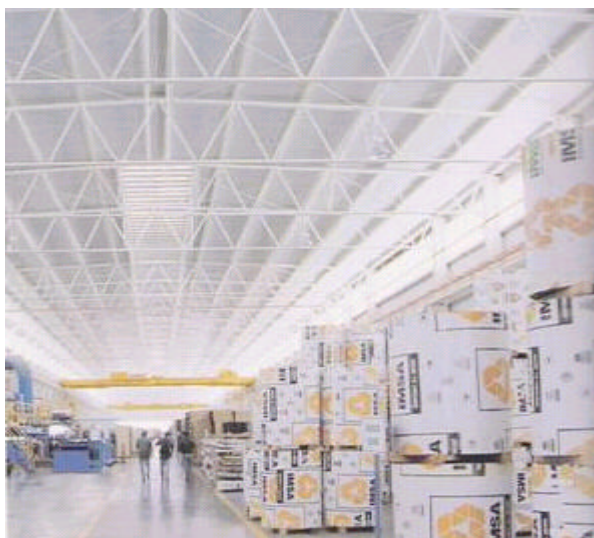
Figura 3. Cubierta metálica para bodega
