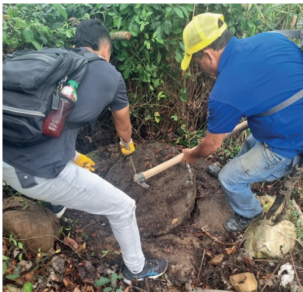
Fotografía 9. Inspección del sistema de recolección y transporte de aguas residuales
