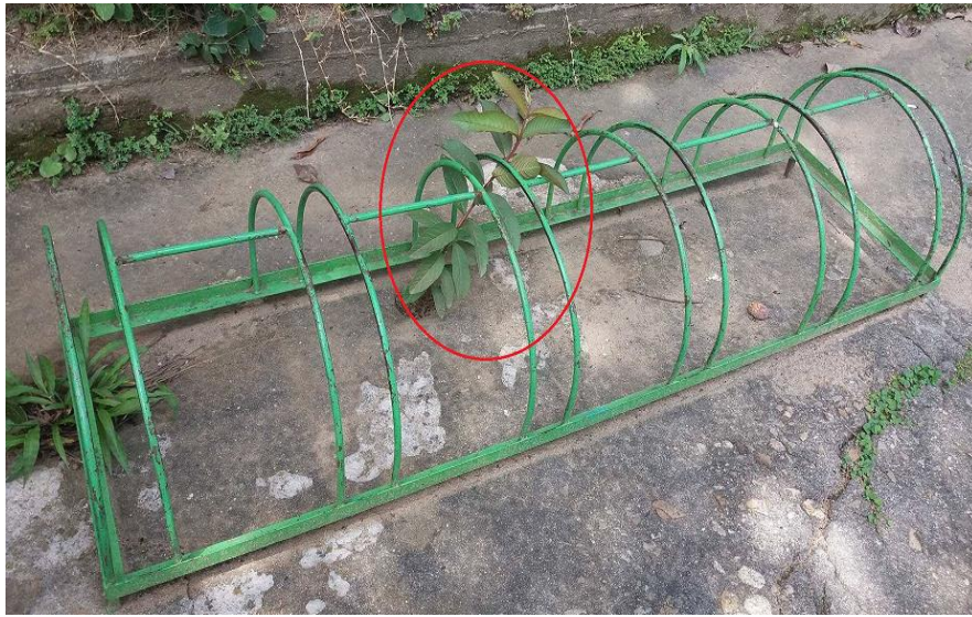
Figura 7. Bastidor obstruido por vegetación.
