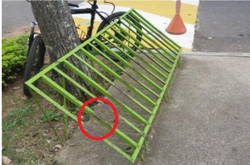
Figura 3. Bastidor con mal estado de pintura.
