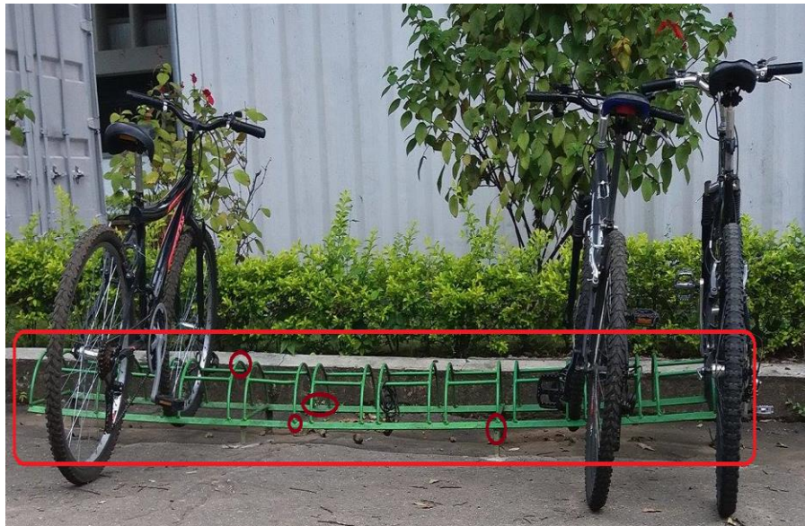
Figura 5. Bastidor oxidado y puesto flexionado.
