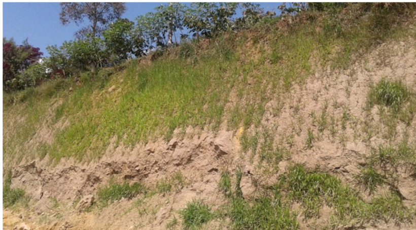
Imagen3. Estabilización de taludes
