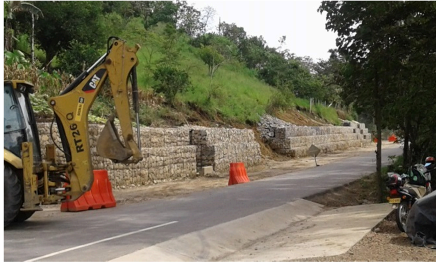
Imagen4. Estabilización muros en gaviones.
