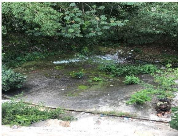
Pantalla en concreto lanzado #1 barrio Nápoles
