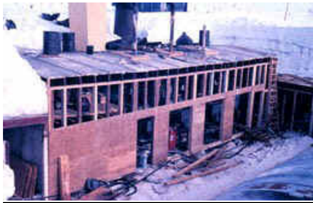
Fotografía 4. Sistema en Mampostería confinada
