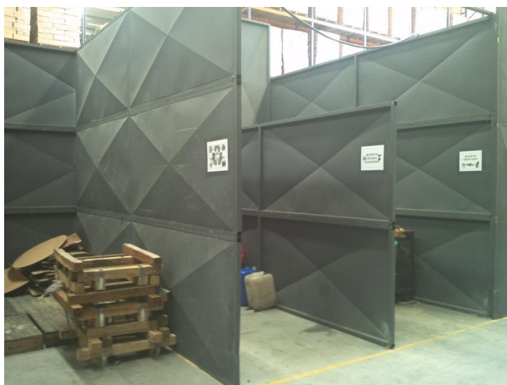
Foto 5. Cuarto de almacenamiento temporal de residuos sólidos
