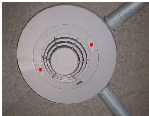
Figura 1.2 Sensor térmico basado en termistor.
