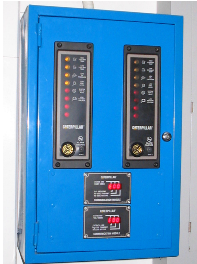
Figura 3.6 Panel en CACYM de los módulos CAM y CCM.
