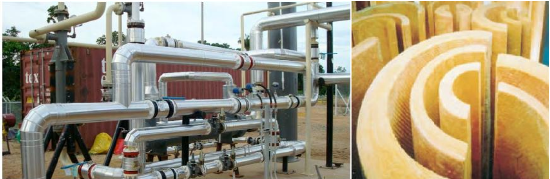
Ilustración 13. Aislamiento térmico Lana de vidrio para tuberías con Cañuelas Alto rango.
