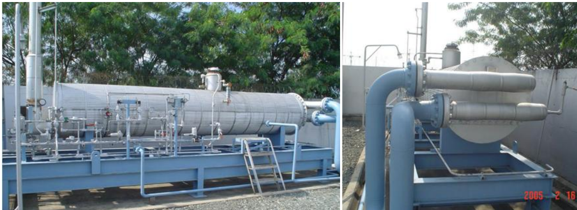
Ilustración 24. Vistas lateral y frontal de Calentador de Fuego Indirecto Citygate Cali.
