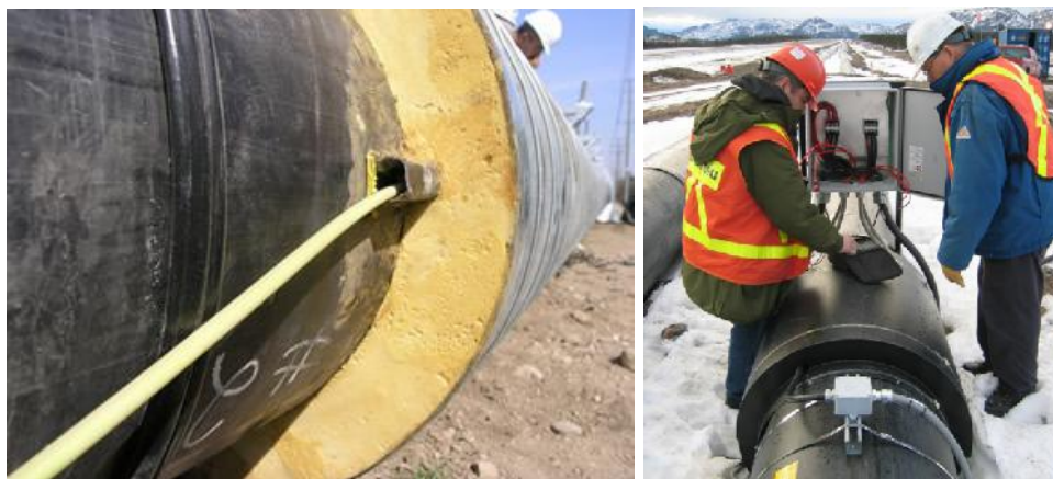
Ilustración 21. Vista de instalación de cables calefactores y controlador de potencia.
