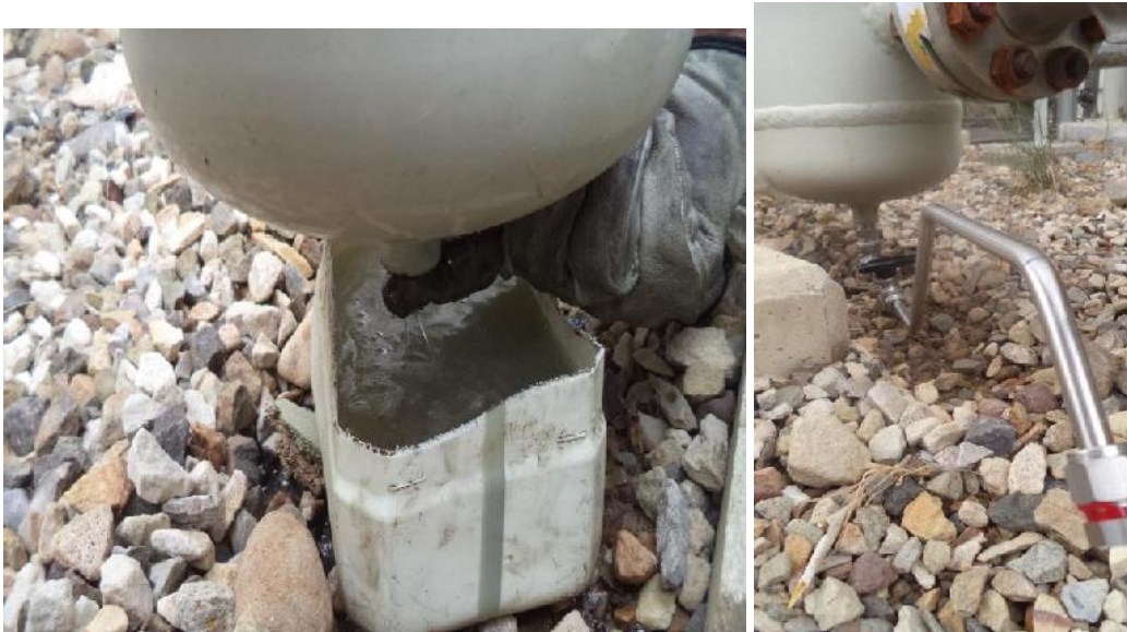
Ilustración 32. Acondicionamiento de drenaje en sistema de filtrado.
