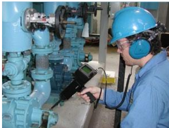
FIG 5 Inspección mecánica con equipo de ultrasonido en bombas
