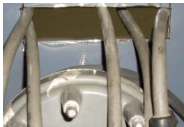
Figura 35: Instalación del Cableado de Alta.
