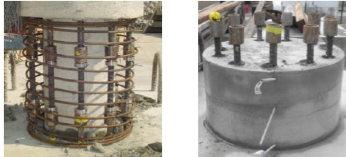
Figura 9. Izquierda: Acopladores con cabeza y rosca sin pedestal prefabricado. Derecha: Acopladores con cabeza y rosca con pedestal.
