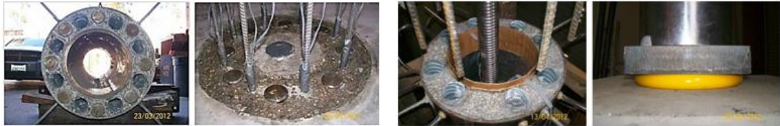
Figura A.29. Columnas de prueba.
