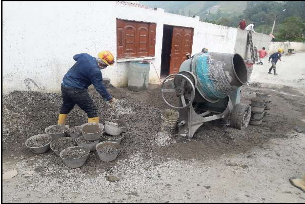
Figura 24. Elaboración del concreto en sitio
