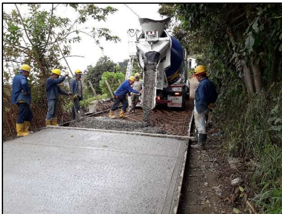
Figura 13. Aplicación de la capa de Pavicreto con MIXER
