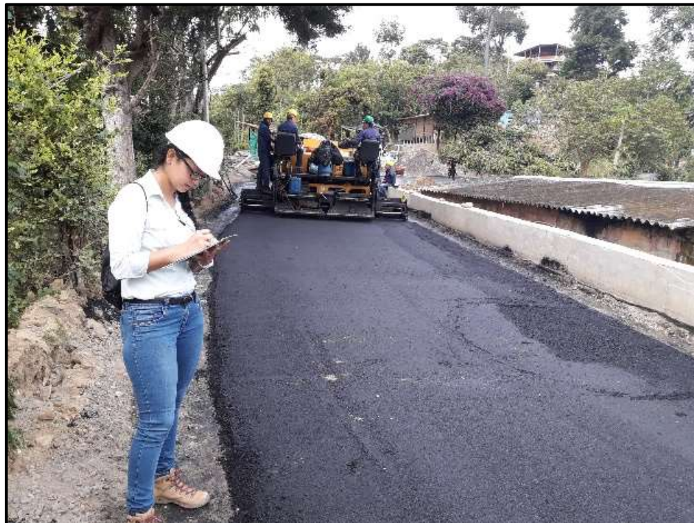
Figura 6. Aplicación de la 1ra capa de Asfalto
