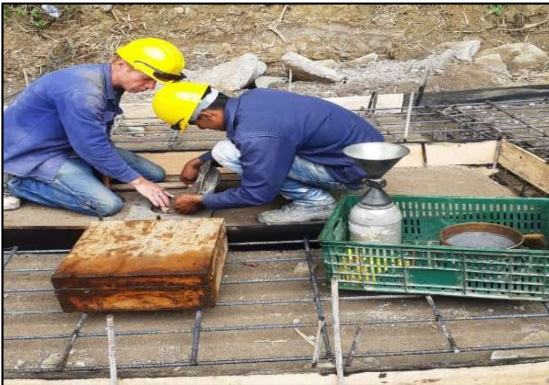
Figura 21. Ensayo de densidad en sitio
