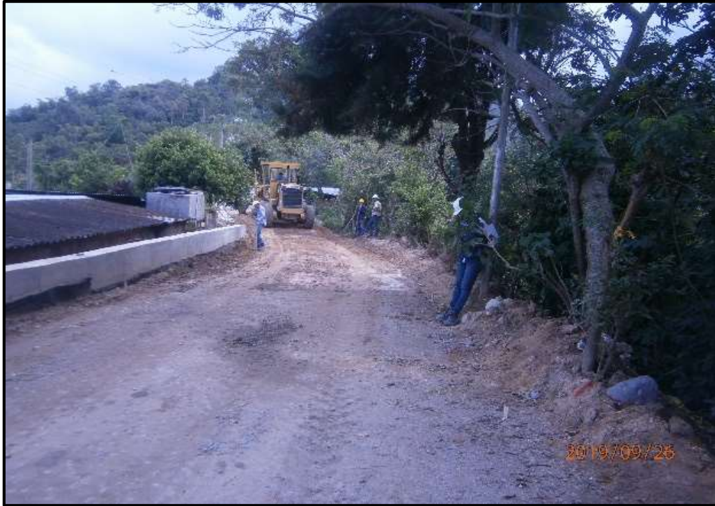
Figura 3. Excavación y Nivelación de Subrasante.
