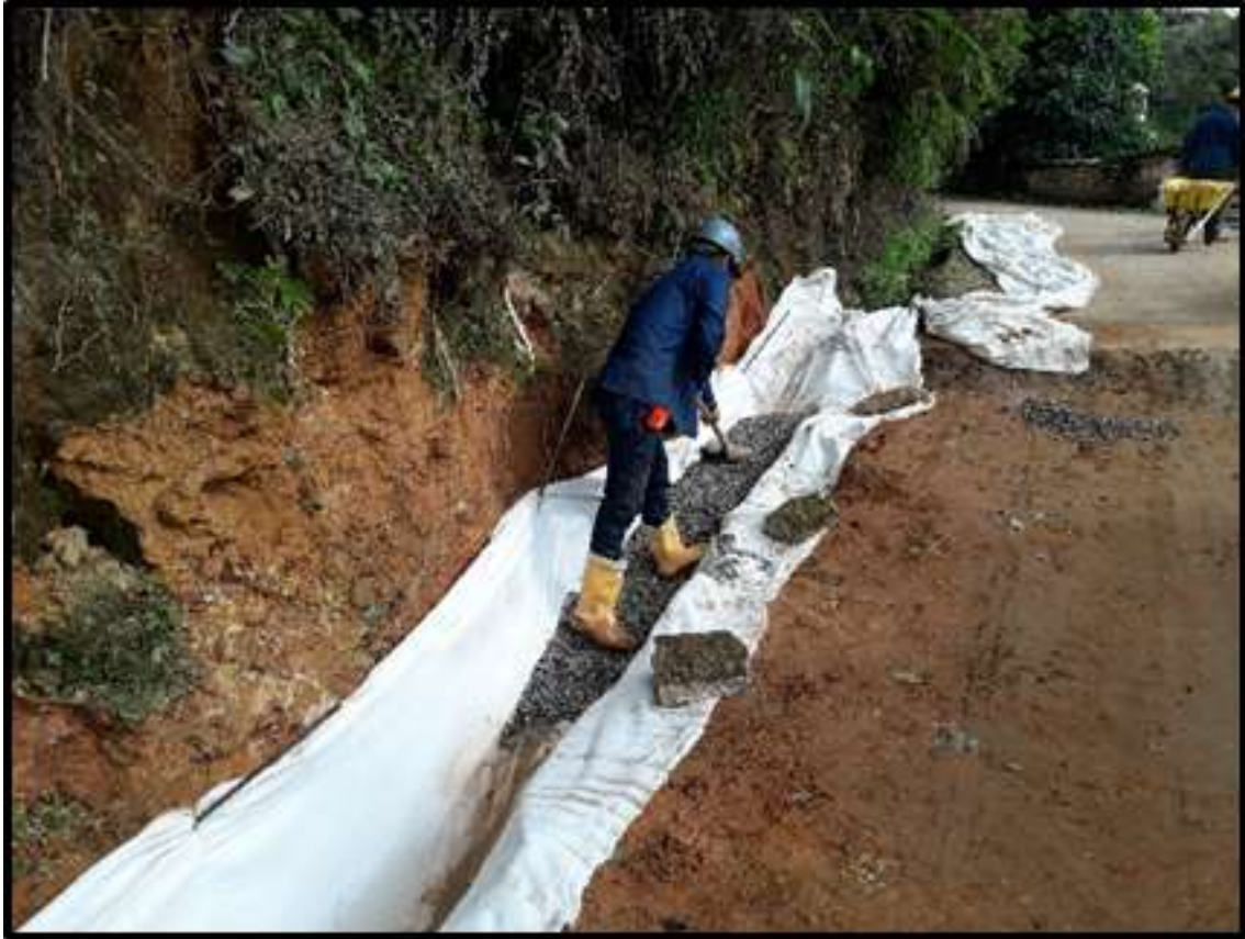
Figura 15. Construcción del filtro
