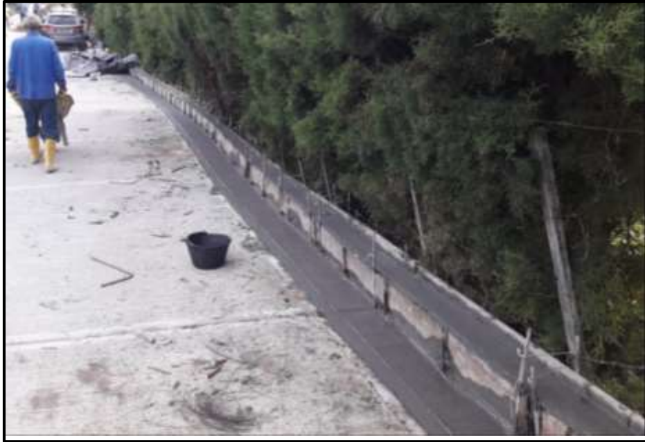
Figura 19. Construcción de Cuneta con Bordillo
