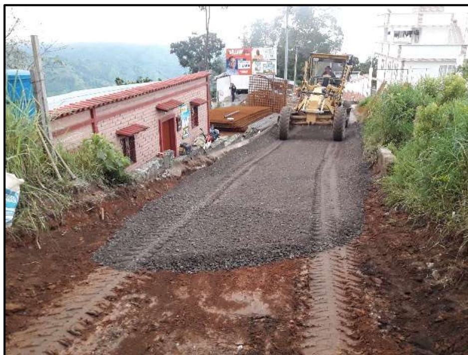
Figura 11. Aplicación de Base Granular.
