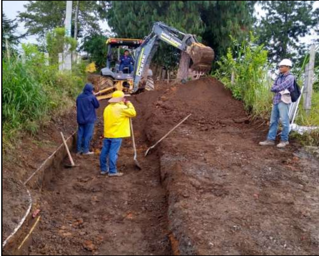
Figura 16. Excavación y Movimiento de tierra
