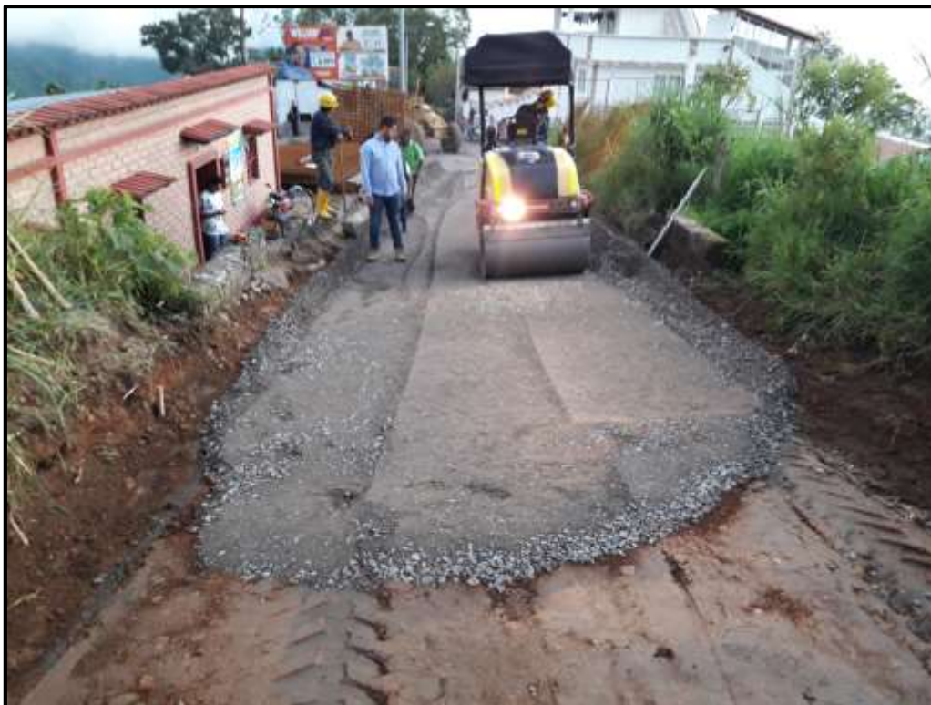
Figura 12. Humectación y compactación adecuada de Base Granular.
