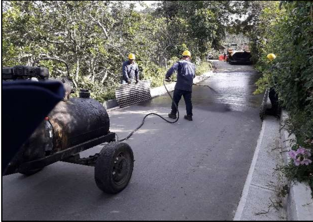
Figura 7. Imprimación sobre la 1ra capa de Asfalto
