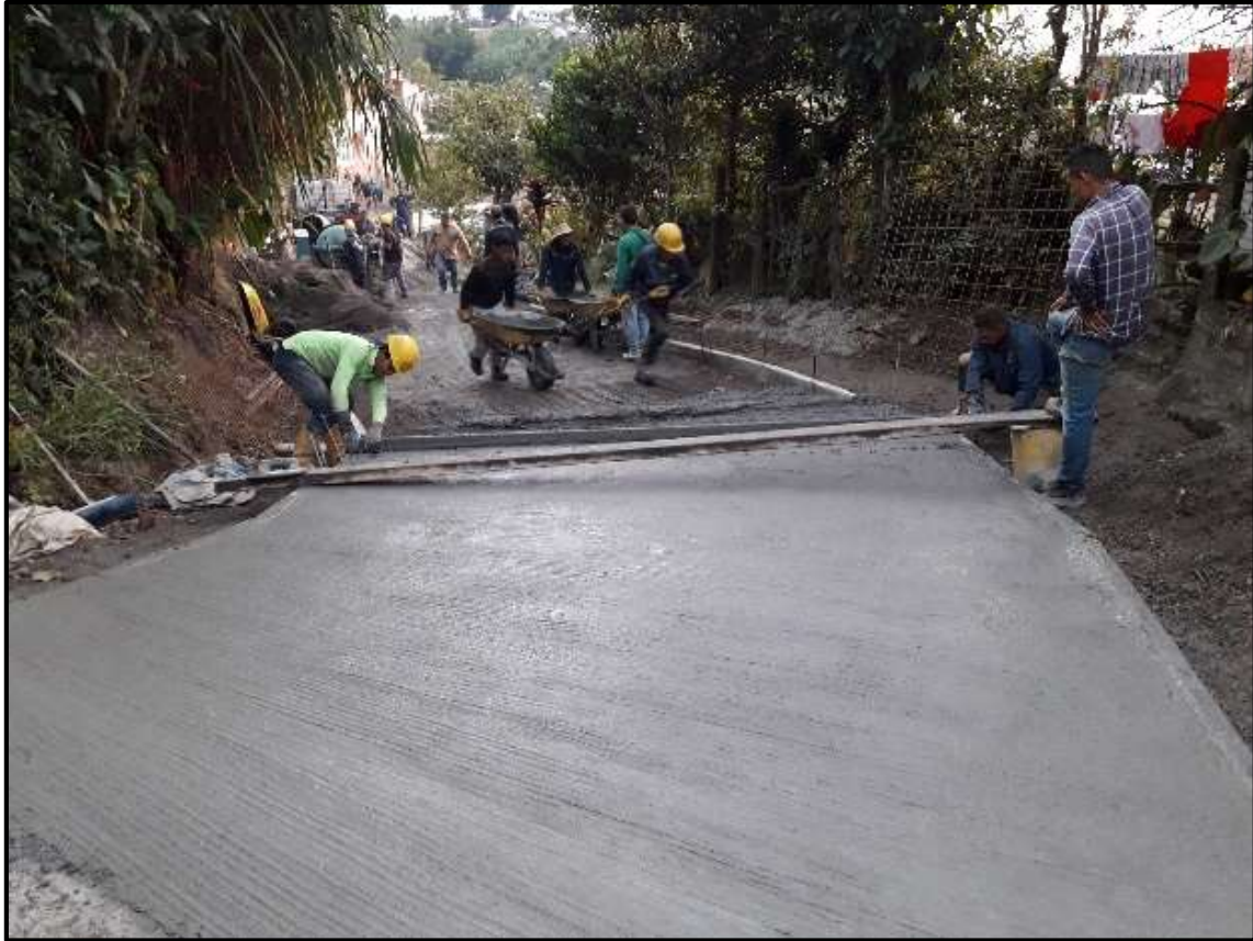
Figura 14. Aplicación de la capa de Pavicreteo con MEZCLADORA
