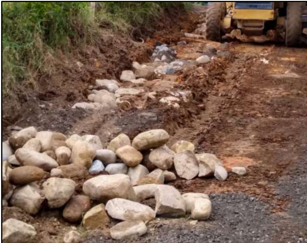
Figura 9. Excavación y Mejoramiento de la Subrasante con Rajón de piedra.
