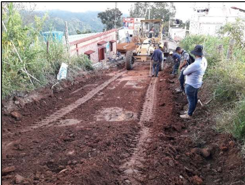
Figura 10. Nivelación de la Subrasante.
