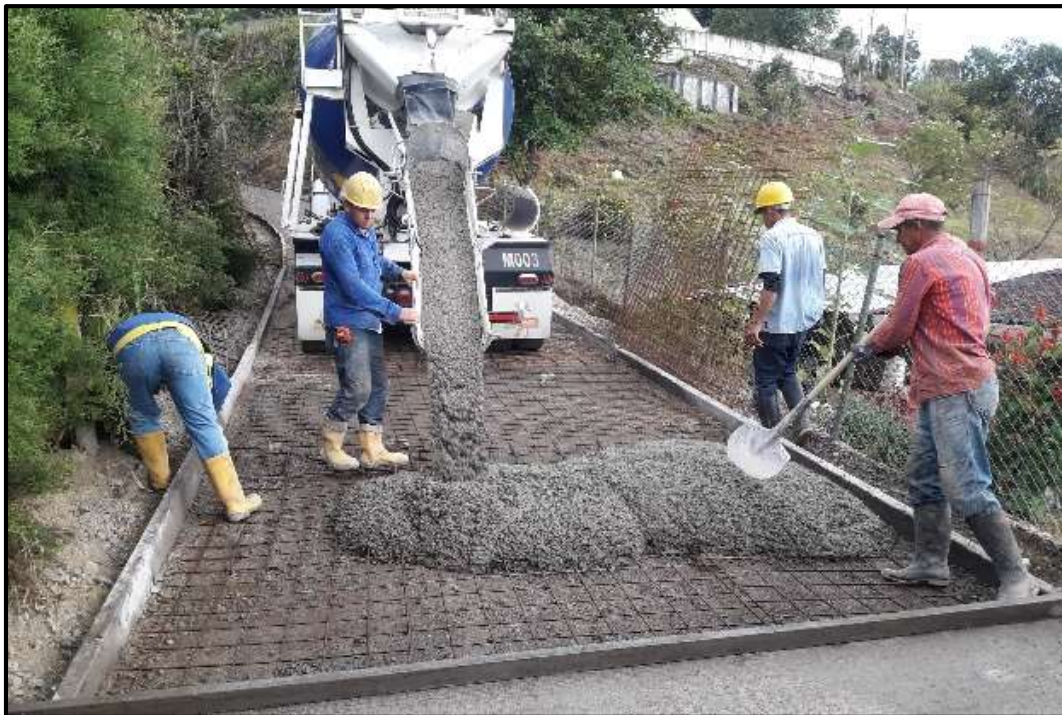
Figura 22. Concreto de Planta
