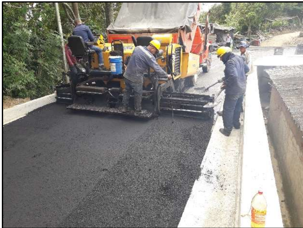
Figura 8. Aplicación de la 2da capa de Asfalto
