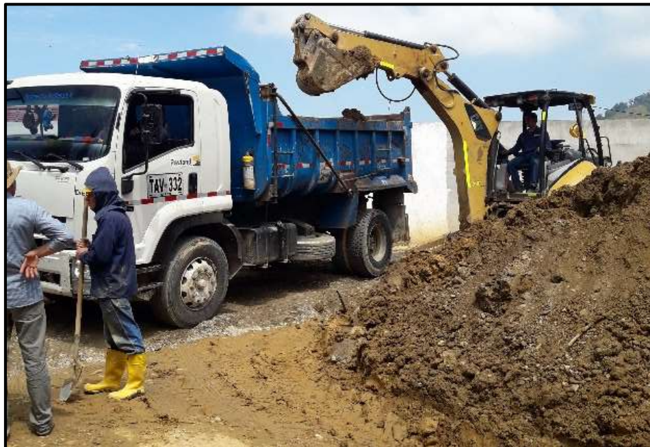
Figura 17. Retiro de Material Sobrante (Botaderos Autorizados).
