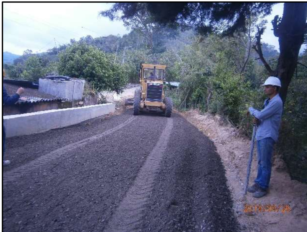
Figura 4. Aplicación de Basa Granular.
