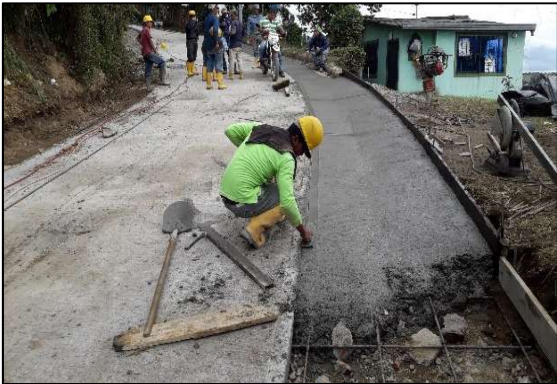
Figura 18. Construcción de Cuneta en V
