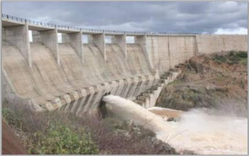
Figura 19. Vaciado del embalse efectuando remoción por chorros de agua. (Sánchez Blum, 2014).
