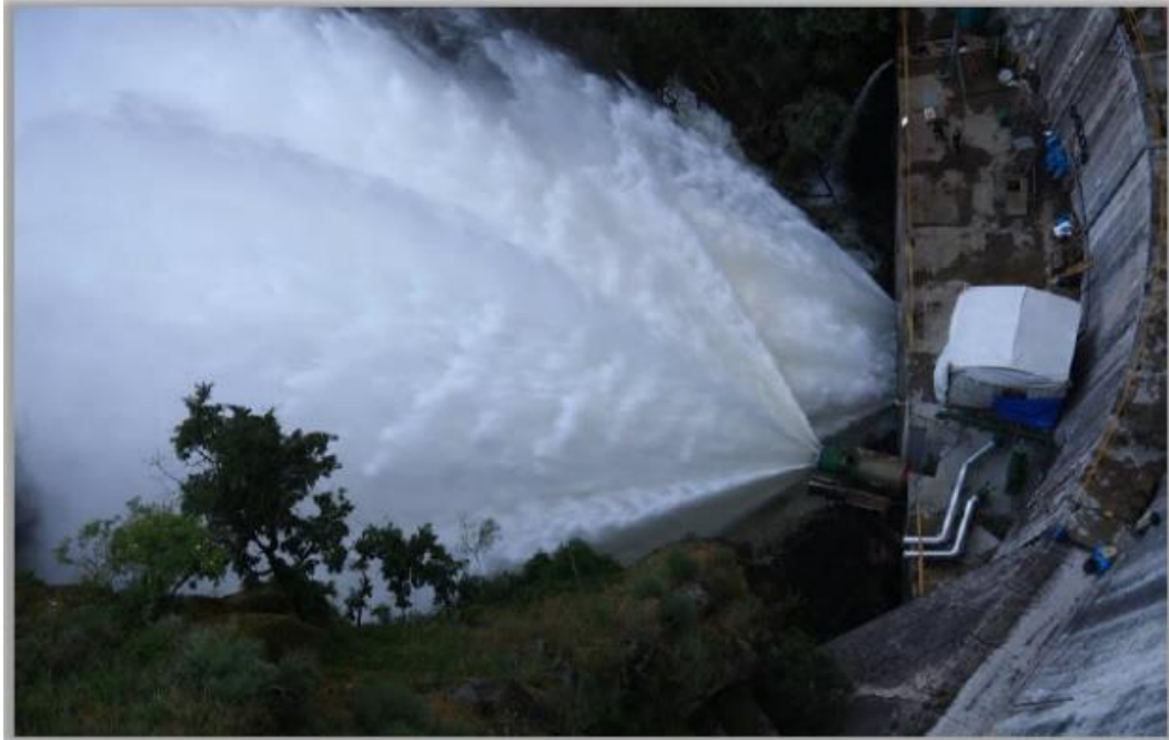
Figura 17. Apertura de los desagües de fondo. Formación de conos de remoción. Presa Belesar España (Cobo, 2008).
