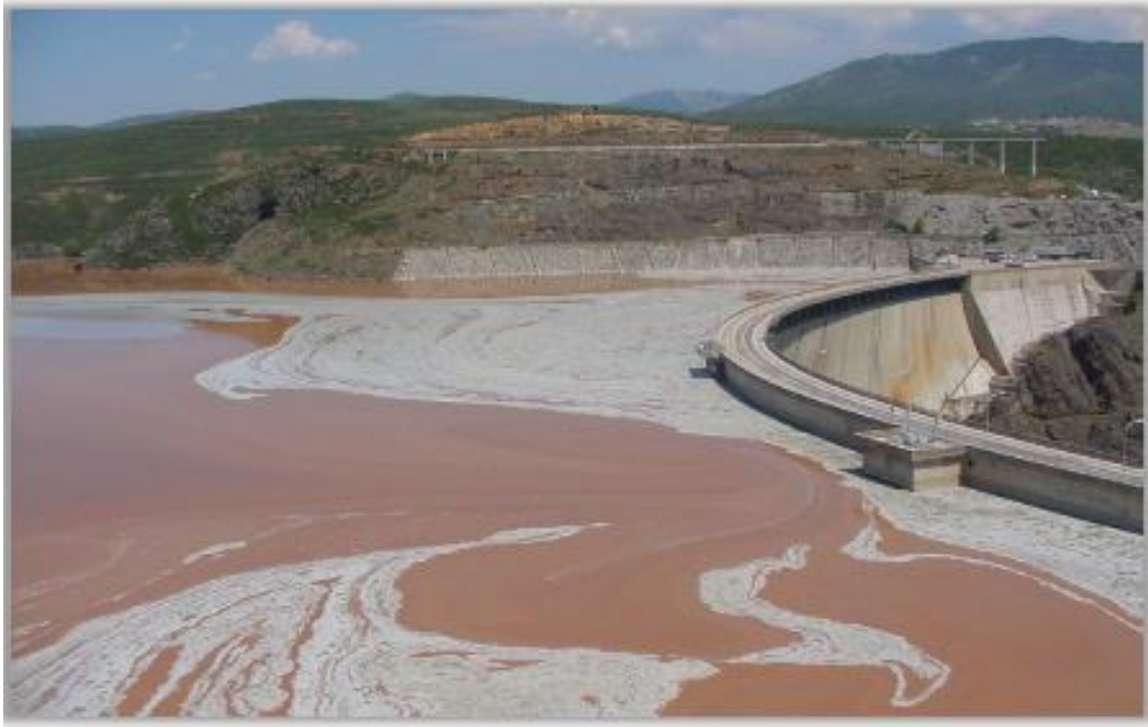
Figura 20. Modelo de corriente de densidad en embalses. (Fuentes Norambuena, 2018).
