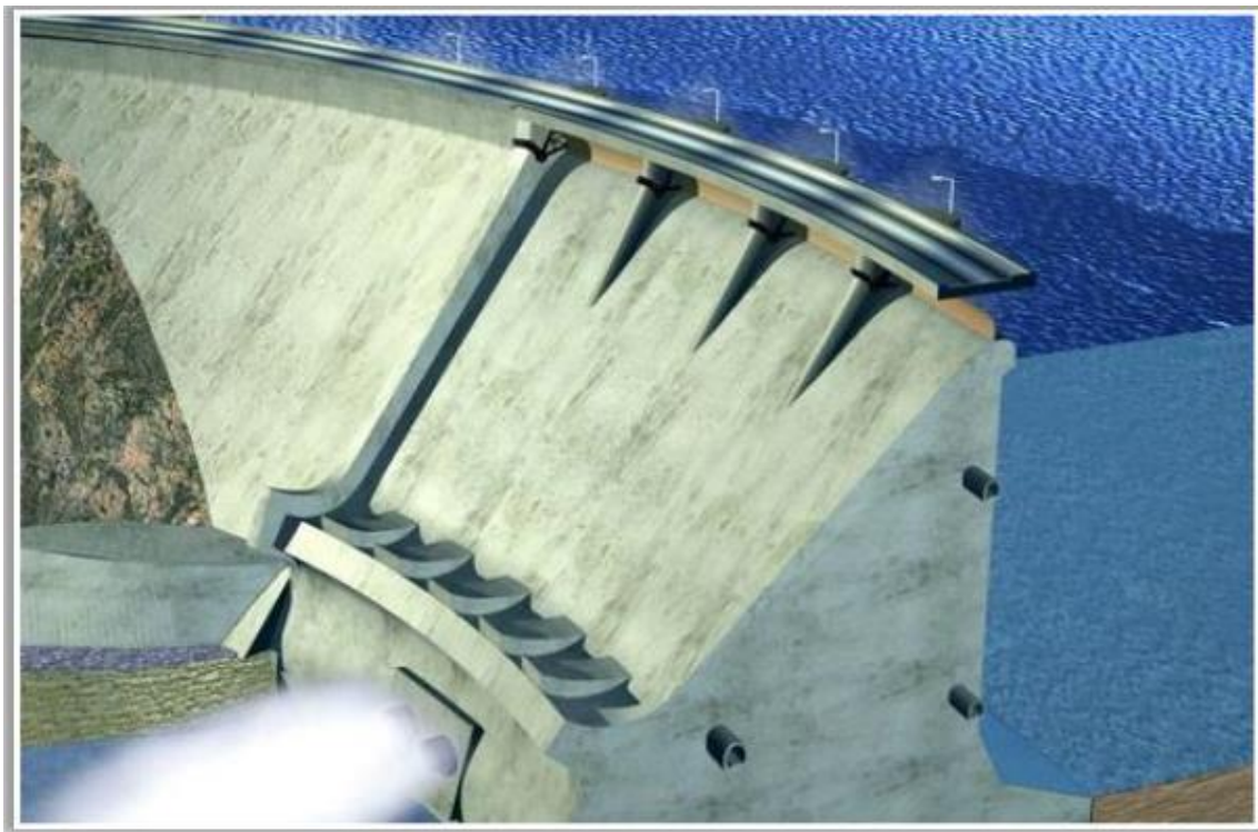
Figura 18. Lavado hidráulico de sedimentos durante avenidas. (Sánchez Blum, 2014).
