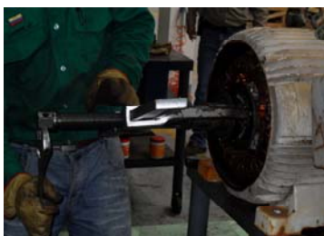
Figura 7. Desmontaje de un rodamiento con extractor.
