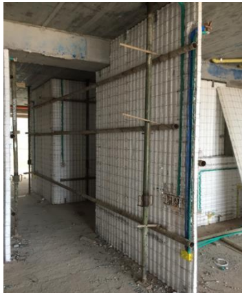
Figura 8. Actividades muros durapanel- aplomar y nivelar muros
