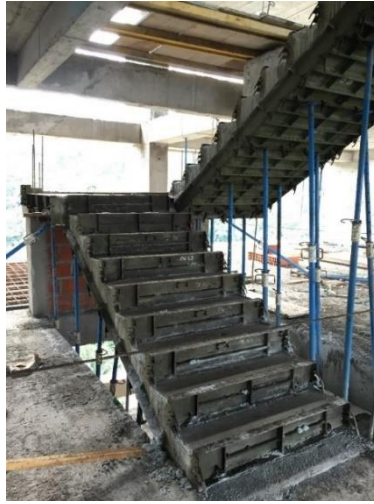
Figura 6. Instalación de encofrado para escaleras
