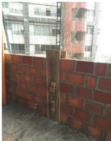
Figura 7. Levantamiento de muros en mampostería y columnetas
