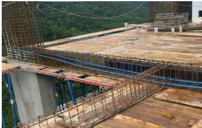
Figura 5. Elementos estructurales horizontales- Vigas
