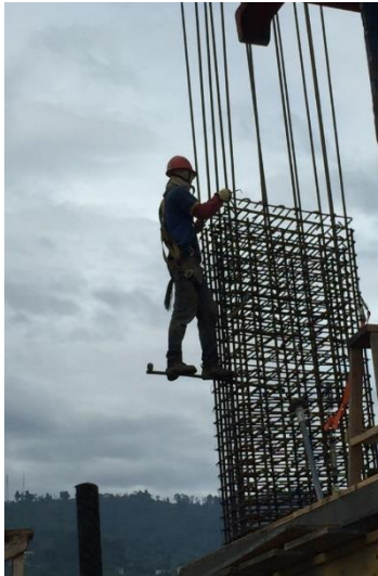
Figura 4. Actividad estructura-armado de refuerzos de acero
