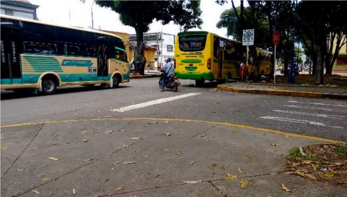
Figura 11. Calle 45 a la altura de la carrera 11, mal estado de la señalización horizontal.
