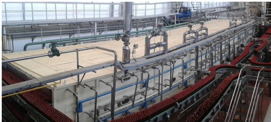
Figura 11. Pasteurizador. Adaptado del Área de Embotellado de Bavaria Bucaramanga
