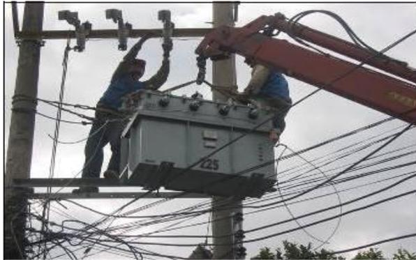
Antes de realizar cualquier trabajo sobre un transformador asegurarse de que se encuentre totalmente desenergizado de su fuente de alimentación.
