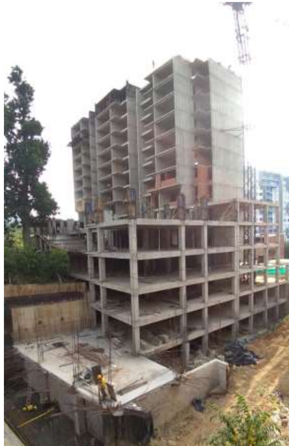
Figura 11: Avance de obra al finalizar la practica
