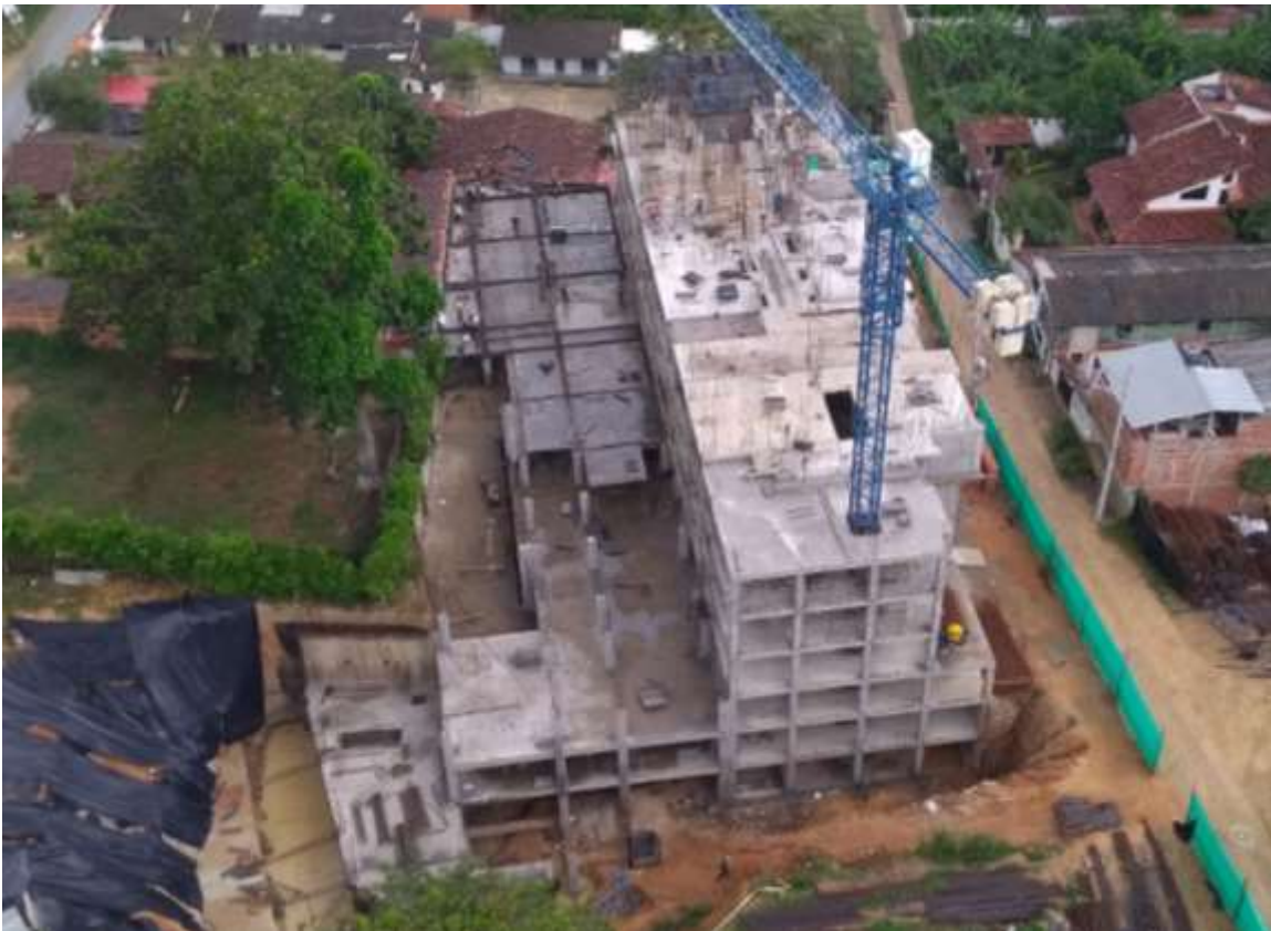
Figura 4. Avance de la obra al inicio de la práctica.
