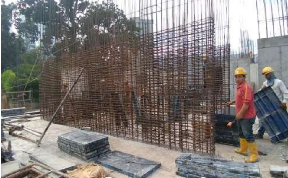
Figura 5: Instalación de acero en un muro estructural.
