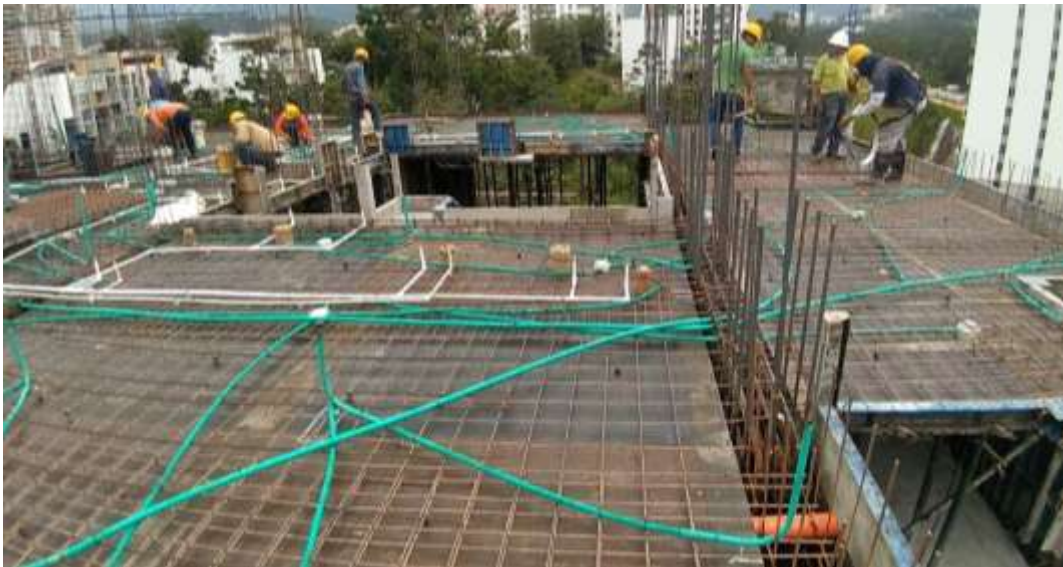
Figura 9. Instalación de redes eléctricas e hidráulicas.
