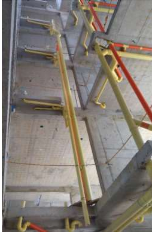
Figura 10. Instalación de tubería sanitaria y de ventilación.
