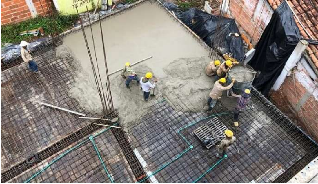
Figura 7. Colocación de concreto con balde de la torre grúa.
