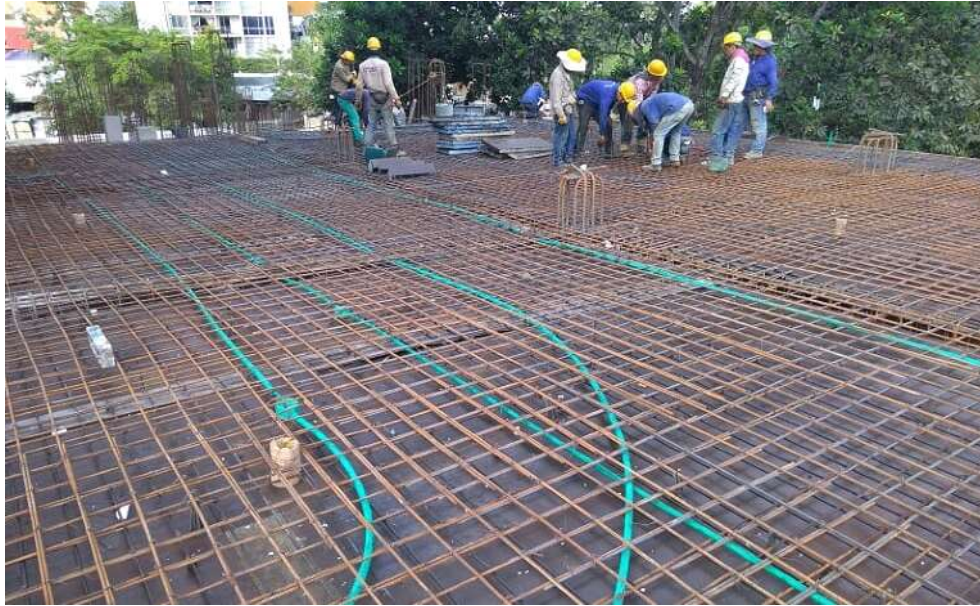
Figura 6. Acero instalado en placa de entrepiso.
