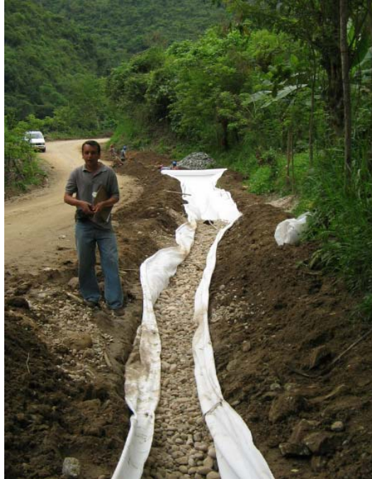
Figura No. 17 Extendido de filtros
