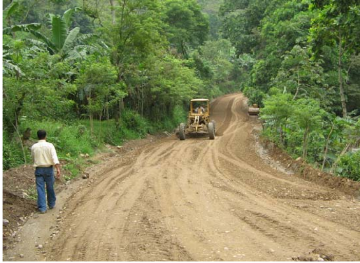
Figura No. 21 Extendido de material subbase
