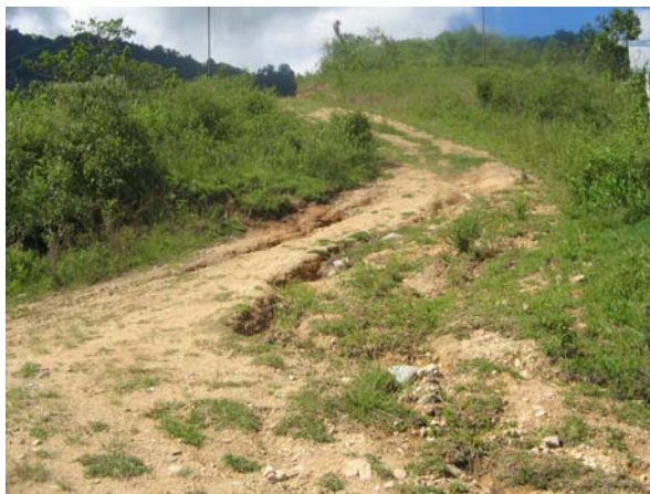
Figura No. 7 Vía Patio Barrio-Pericos
