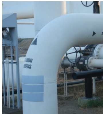
Figura 19: Codo 90° en línea de flujo PF2
