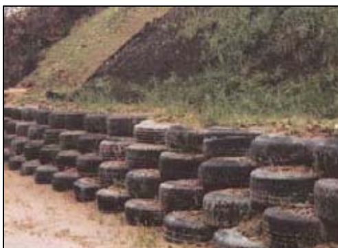
Foto 19 Tratamiento de taludes mediante muros de estabilización con llantas.
