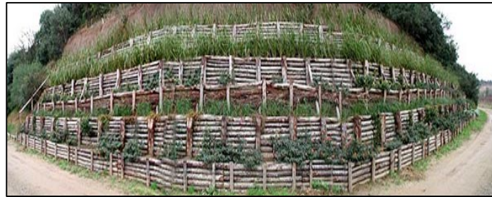
Foto 12 Estabilización de taludes mediante muros de sostenimiento de madera.
