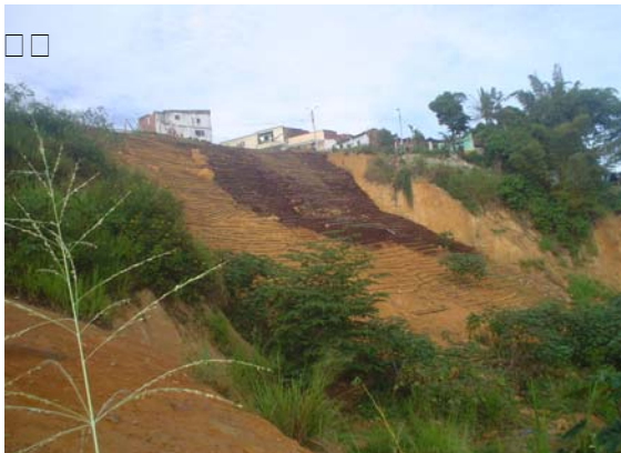
Foto 7. Talud Estable Barrio Nariño.
