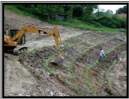
Foto 10 Talud con pendiente estable y siembra de vetiver para asegurar su estabilidad.
