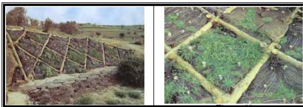
Foto 16 Vista general de estabilización con postes de madera y polisombra para el control de la erosión en taludes de Sabana de Torres, detalle de la estabilización a través de la siembra y confinamiento de pastos.
