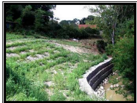
Foto 10 Talud con pendiente estable y siembra de vetiver para asegurar su estabilidad.
