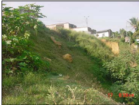
Foto 8 Talud totalmente recuperado.
