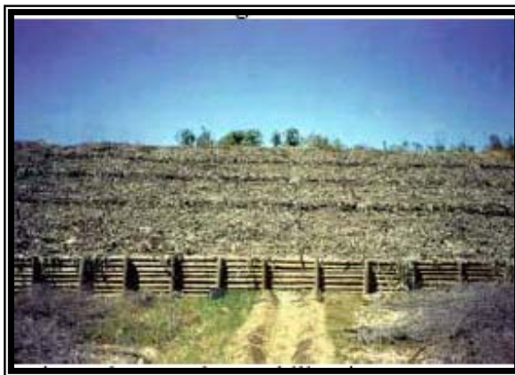
Foto 18 Control y estabilización de canales con tratamientos de postes de madera
