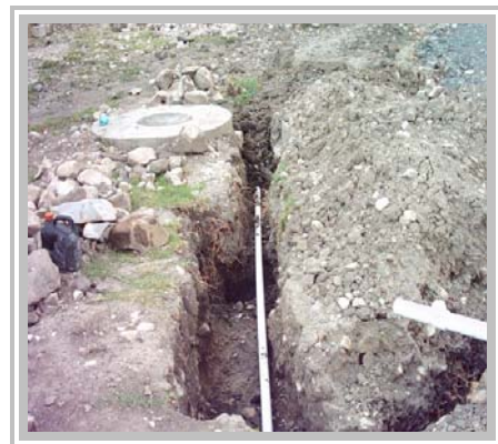
Excavación y colocación de la tubería de 2"
