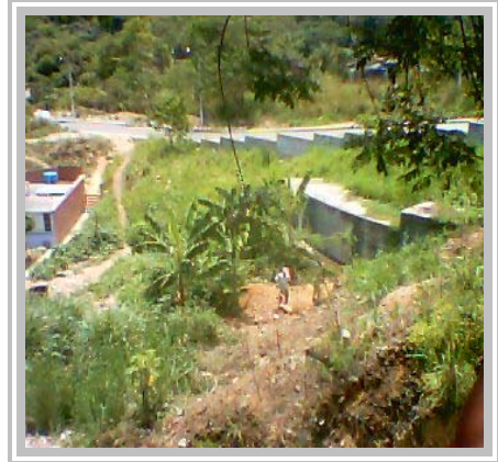
Aspecto general antes de iniciar la obra
