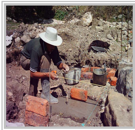
Construcción de las cajas para los micromedidores y válvulas.
