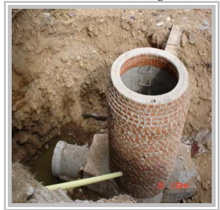
Pozo de inspección
