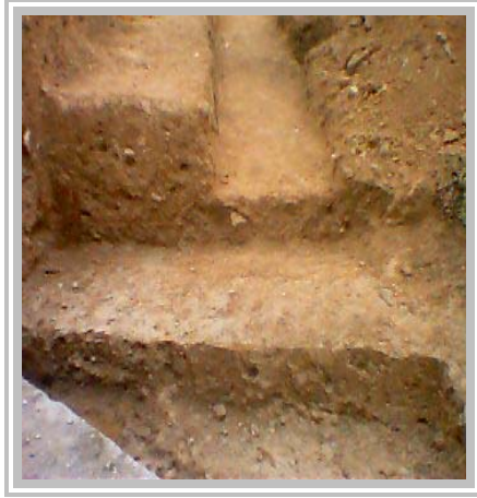
El canal será escalonado
