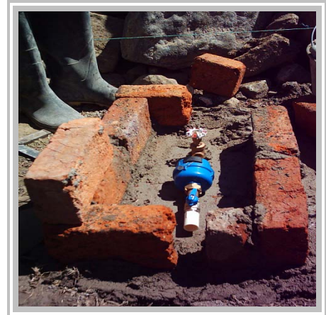
Construcción de las cajas para los micromedidores y válvulas.
