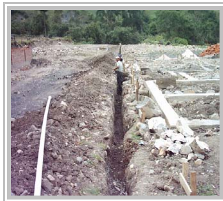
Excavación y colocación de la tubería de 2"
