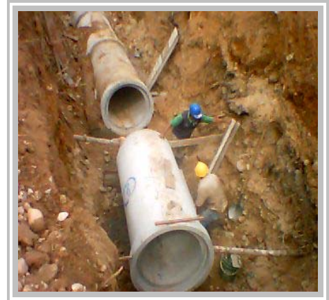
Instalación de Tubería
