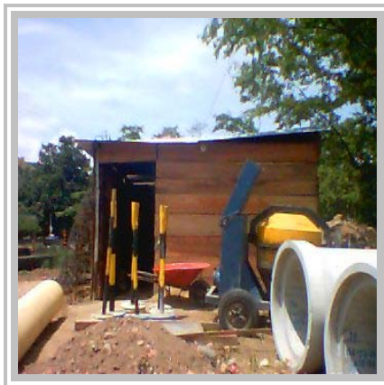
Construcción de Campamento
