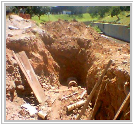
Preparación del terreno para la construcción de pozo de inspección
