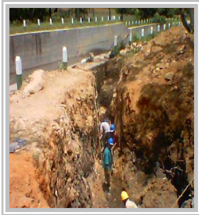
Excavación para descole
