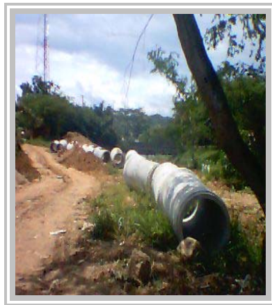
Tubería acordonada
