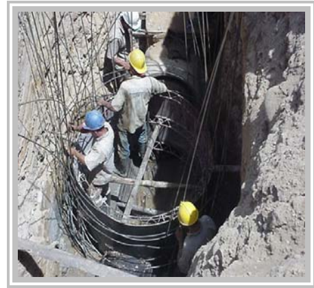
Colocación del acero de refuerzo para los pozos de inspección
