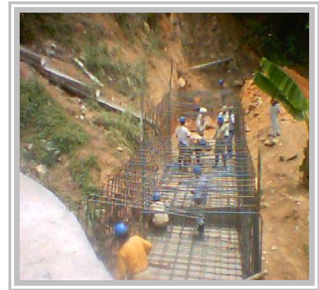
Acero de Refuerzo para el primer tramo para el canal
