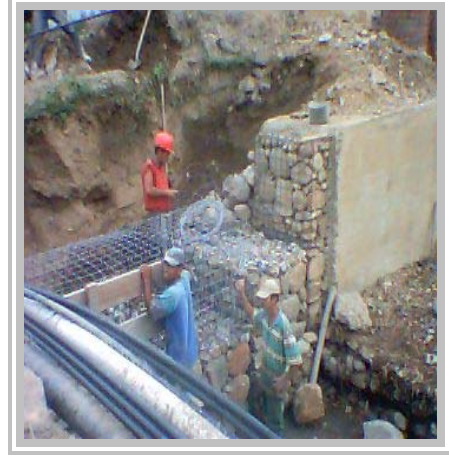
Piso a recuperar en ciclópeo
