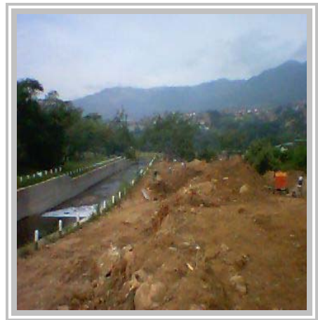
Rellenos y adecuación del Talud resultante
