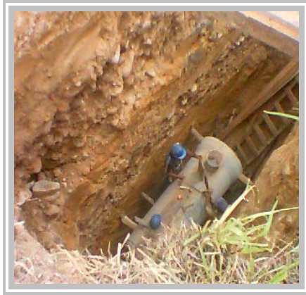
Instalación de la Tubería
